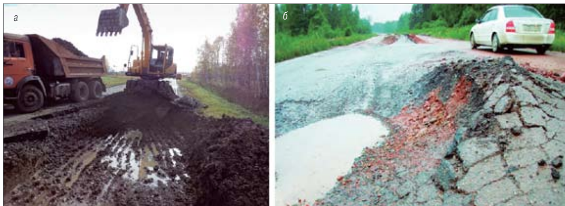
Рис. 2. а – застой воды в насыпи; б – бугор пучения
