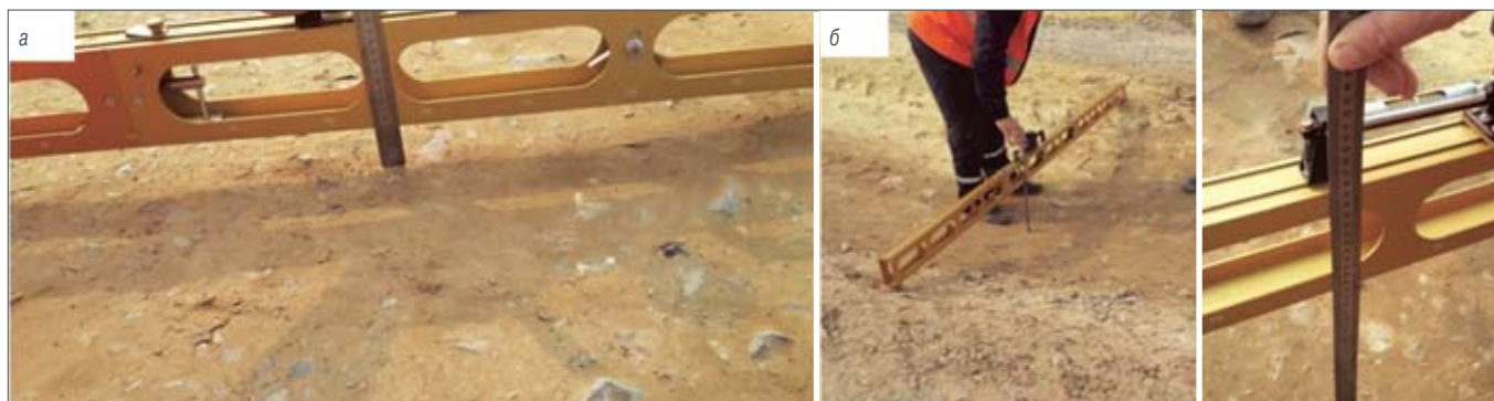
Рис. 3. Колеиность покрытия после прохода карьерных самосвалов: а — участок с механической стабилизацией гексагональной георешеткой Tensar; б — участок без механической стабилизации
