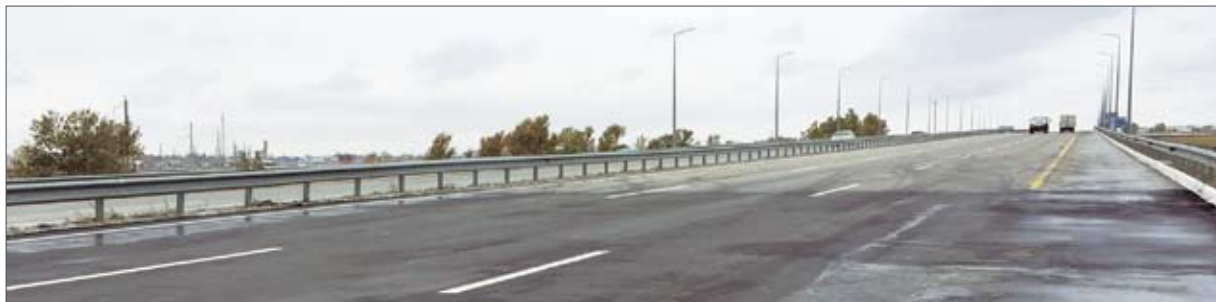
Устранение просадки на дороге Астана – Павлодар
