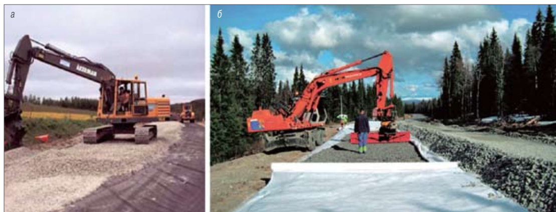
Рис. 4. Укладка морозозащитного слоя из пеностекляного щебня, Норвегия: а – трасса Rv 31, б – двухстадийное строительство (фото: www.hasopor.se)
