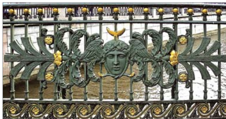
Решетка перильного ограждения Театрального моста
