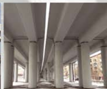
Транспортный путепровод на Волоколамском шоссе
