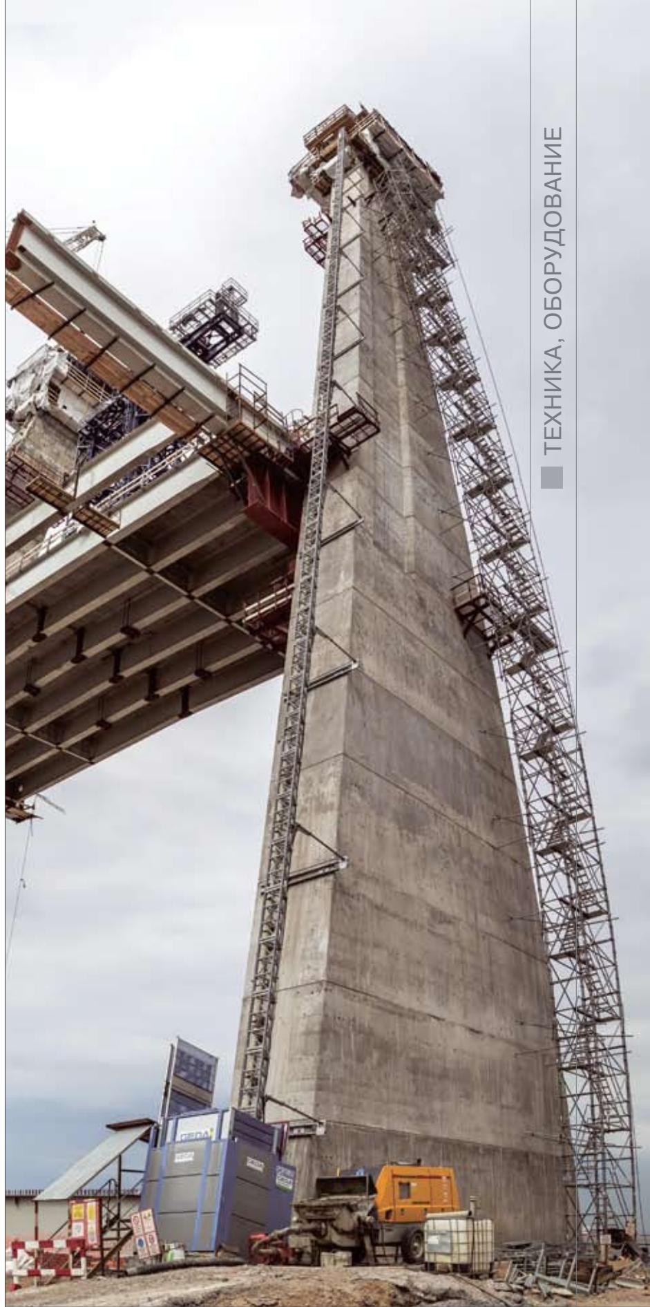
GEDA Multilift P12 на пилоне моста через Корабельный фарватер, г. Санкт-Петербург
