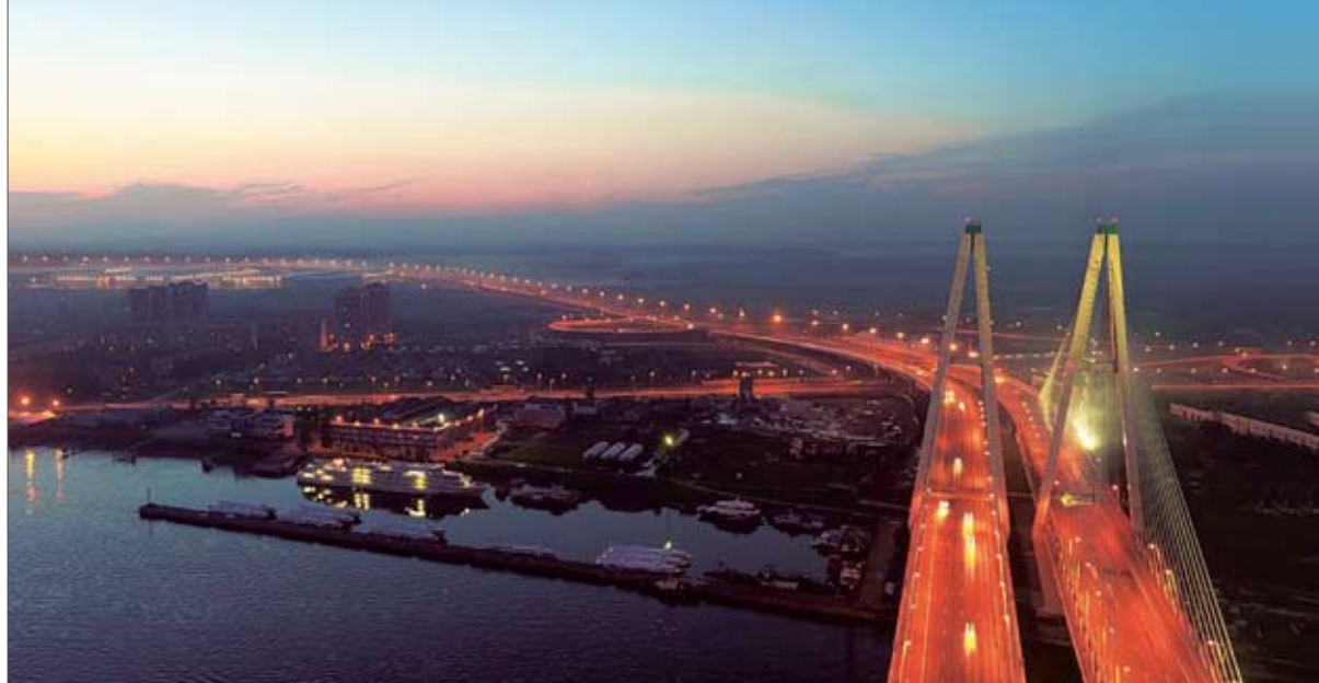
Большой Обуховский мост через р. Неву с транспортными развязкам у съезда с моста
