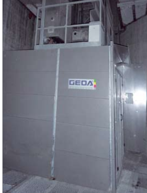
GEDA SH 1250 в пилоне Золотого моста, г. Владивосток
