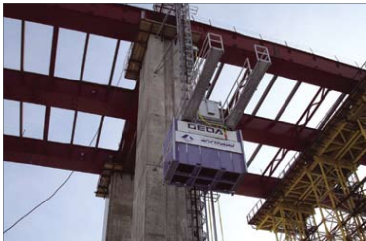
GEDA PH 650 2032 на пилоне Русского моста, г. Владивосток
