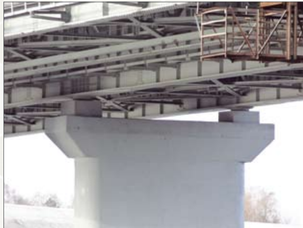
Шаровые сегментные опорные части на мосту через р. Проню на автодороге М-5
