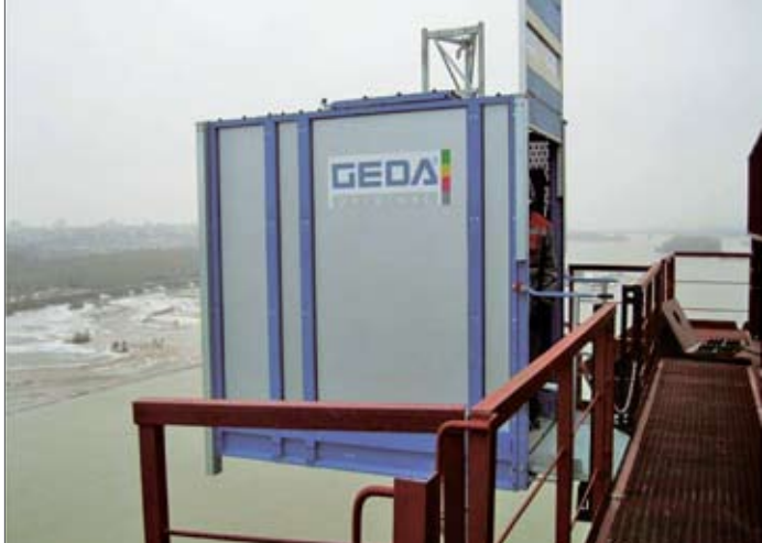
GEDA Multilift P12 на временной опоре Бугринского моста, г. Новосибирск
