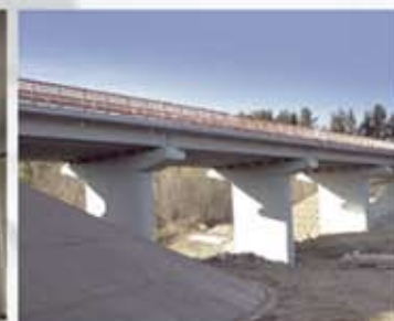
Ремонт моста через р. Падемыга на 634+990км автомобильной дороги М-8
