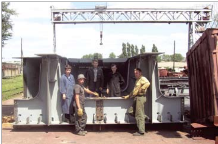
Старший мостовой инспектор А. М. Зацепин (ОАО «Воронежстальмост») ведет приемку заводской контрольной сборки автодорожного пролетного строения для строительства КАД в Санкт-Петербурге
