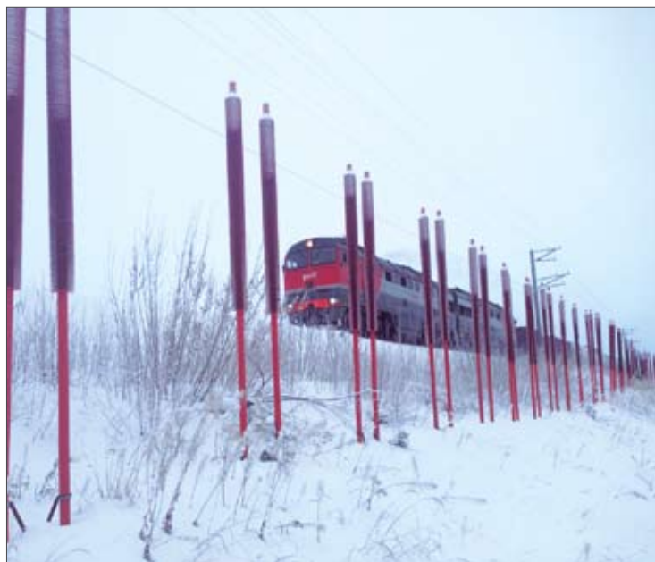
Рис. 2. Термостабилизация ж/д полотна Коротчаевской дистанции пути Свердловской железной дороги
