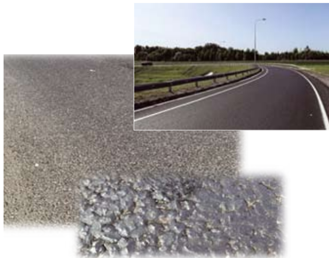
Ремонт транспортной развязки в разных уровнях на км 785+747 автомобильной дороги М-7 «Волга» Москва – Владимир – Нижний Новгород – Казань – Уфа, Республика Татарстан (ЩМА-20 по ГОСТ 31015-2002)
