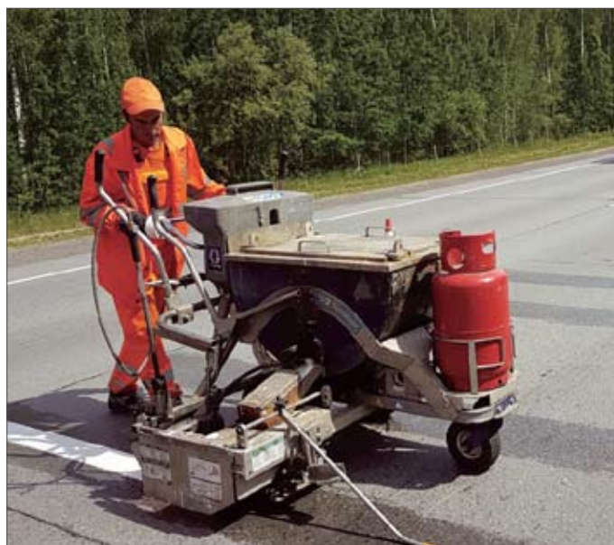
Рис. 7. Нанесение контрольной линии термопластиком на подгрунтованную поверхность цементобетонного покрытия в 2017 году
