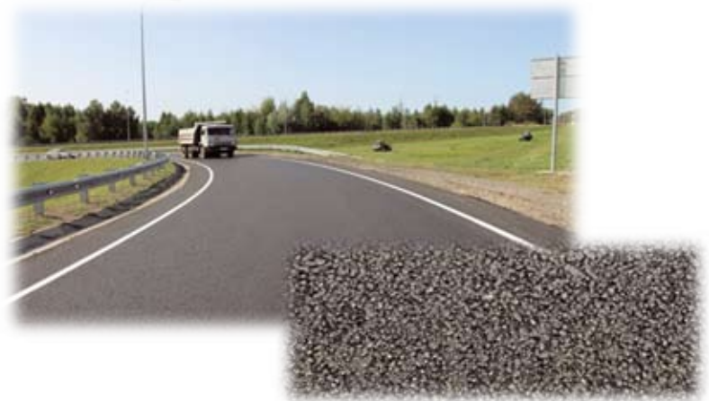
Ремонт транспортной развязки в разных уровнях на км 785+747 автомобильной дороги М-7 «Волга» Москва – Владимир – Нижний Новгород – Казань – Уфа, Республика Татарстан (ЦМА-19 по ПНСТ 127-2016)
