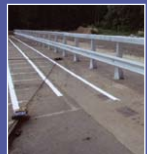
Одностороннее барьерное ограждение с применением двух балок типа «W» на подъезде к г. Жуковский от трассы М-5 «Урал»
