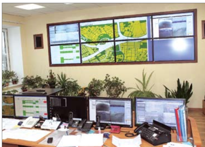
Рис. 4. Помещение диспетчерского пункта СПб ГБУ «Мостотрест»
