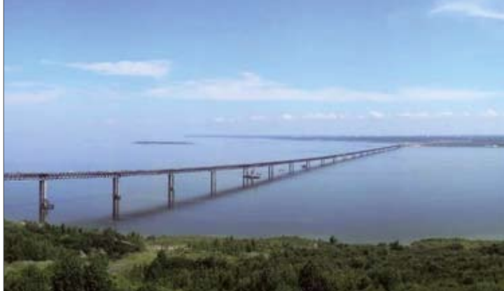
Совместный мост в г. Ульяновск через р. Волгу
