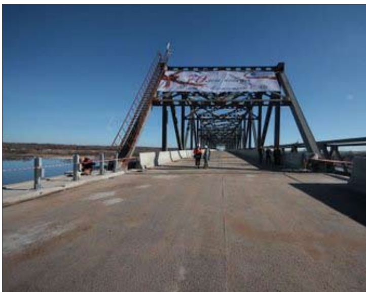
Мост через р. Волхов на км 122+085 трассы Р-21 «Кола»
