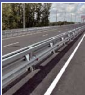
Двухстороннее барьерное ограждение с применением балок типа «W» и «С» на мостовом переходе Северного обхода г. Рязани
