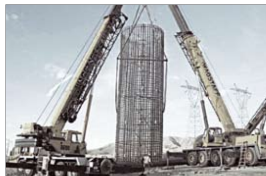
Рис. 7. Установка оболочки в свайную скважину большого диаметра ( https://www.foundationtechnologies.com )
