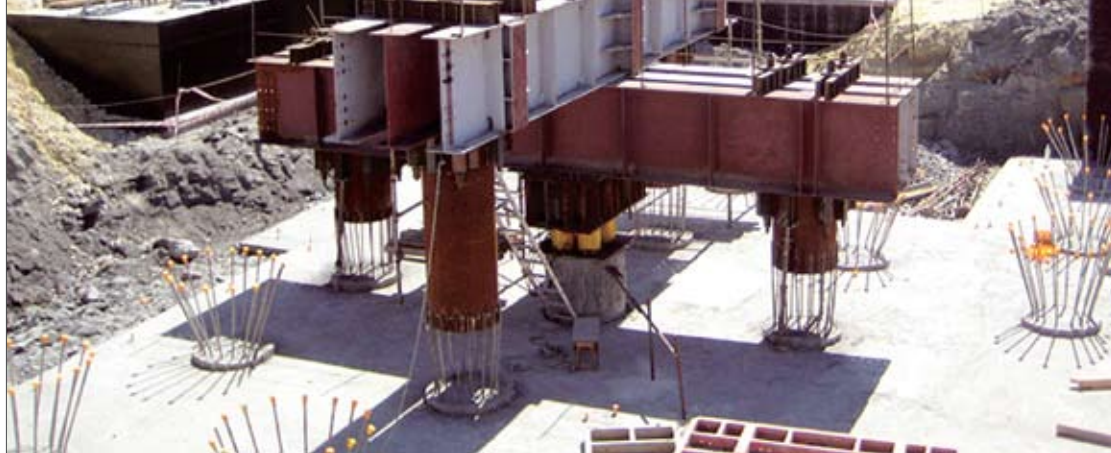
Рис. 1. Пример стэнда для проведения статических испытаний
