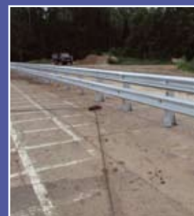
Испытание на полигоне нового мостового барьерного ограждения с применением балок «W» и «С»
