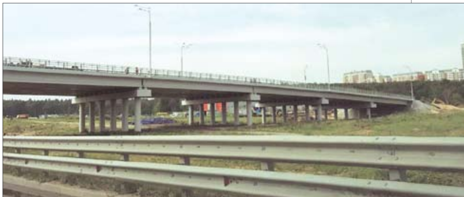
Путепровод над Симферопольским шоссе
