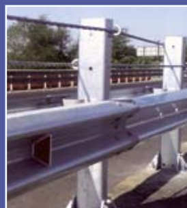
Комбинированное ограждение на мостовом переходе трассы А-280 Ростов-на-Дону – Таганрог – граница с Украиной
