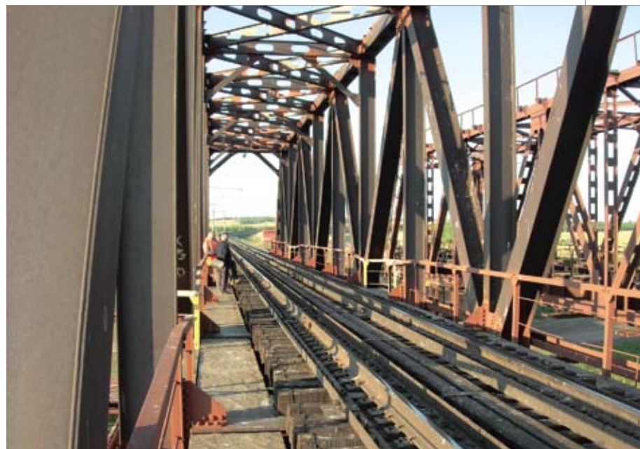
Мост через р. Камышлы-Аят, ЮУЖД
