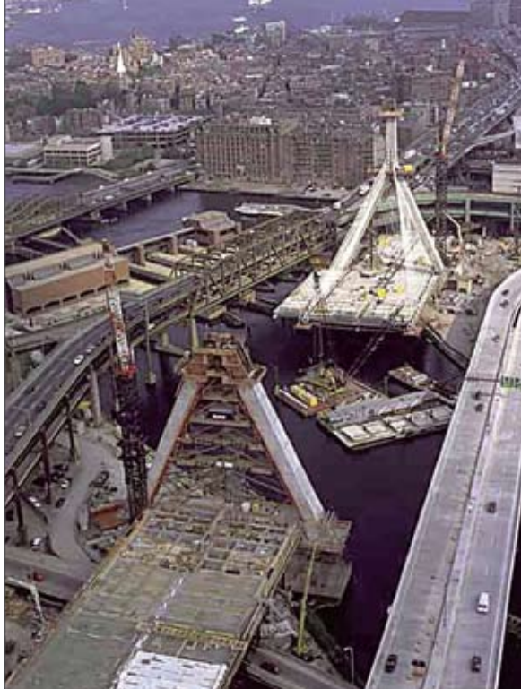
Рис. 11. Строительство моста ( https://www.pinterest.se )
