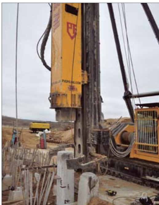
Рис. 2. Проведение динамических испытаний ж/б призматической сваи
