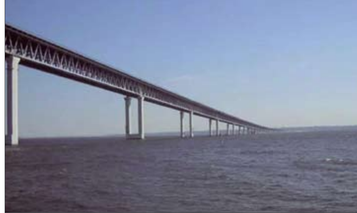
Президентский мост, г. Ульяновск
