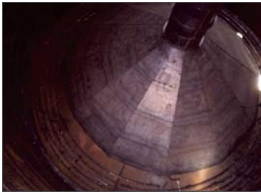
Рис. 3. Система внутреннего нагрева битума КУПОЛ™
