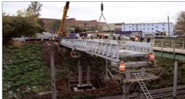
Рис. 2. Монтаж центрального пролета пешеходного моста через железнодорожные пути в районе платформы Чертаново Московской железной дороги
