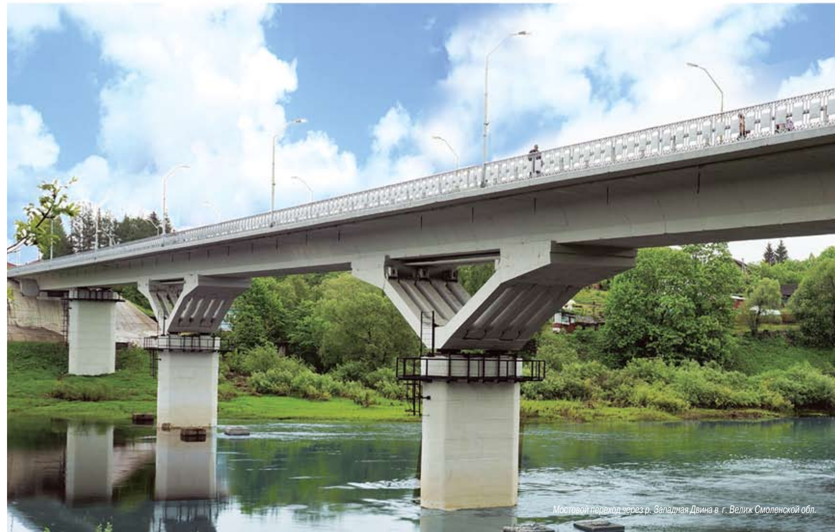
Никольский мост в Кинешме через р. Кинешемку
