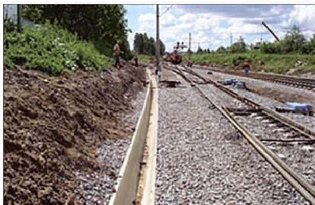
Рис. 1. Водоотводный лоток на железнодорожной линии
