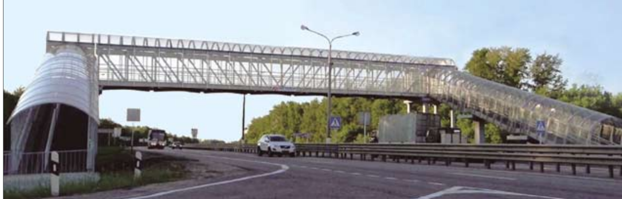
Рис. 3. Пешеходный путепровод на трассе М-4 «Дон» (расчетный пролет 32,9 м), построен в июле 2013 года
