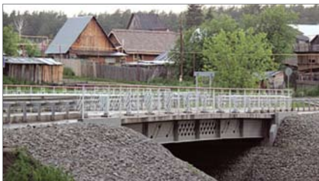
Рис. 4. Гибридный автодорожный мост через реку Пашенка длиной 18,5 м
