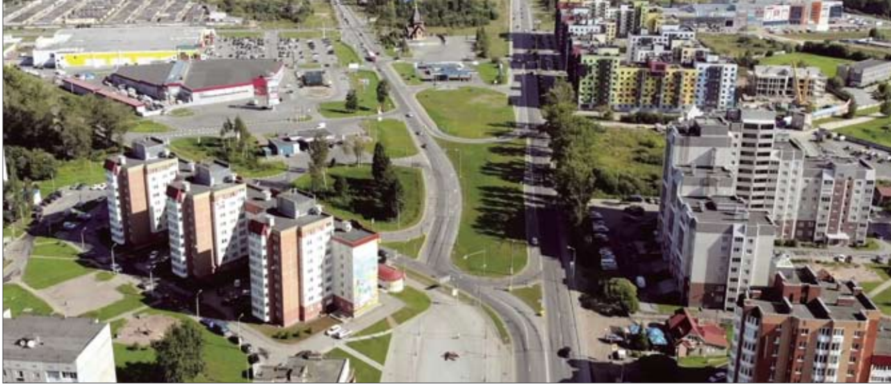
Реконструкция автомобильной дороги «Красное Село – Гатчина – Павловск» на участке км 14+600 км 18+000
