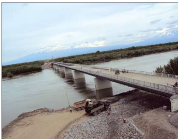
Автодорожный мост через р. Камчатку
