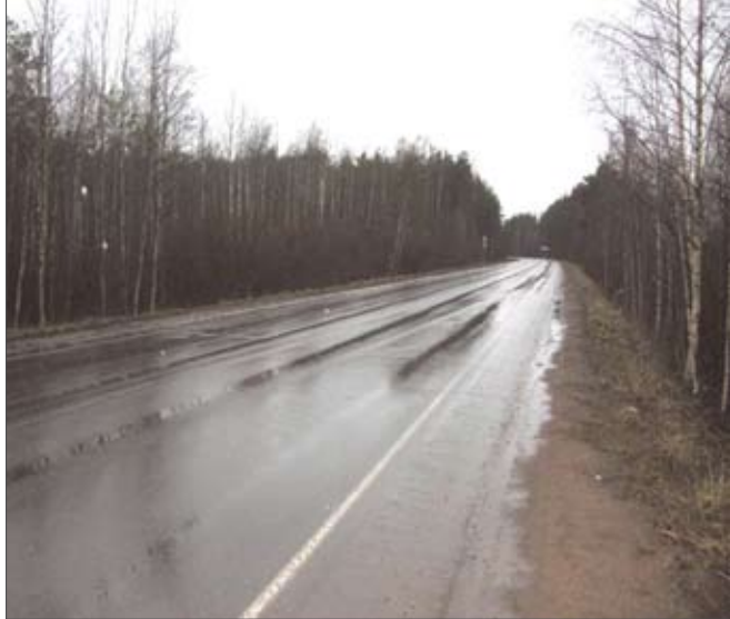
Рис. 2. Застой воды в центре колеи — основная причина перехода колеи в третью, опасную стадию
