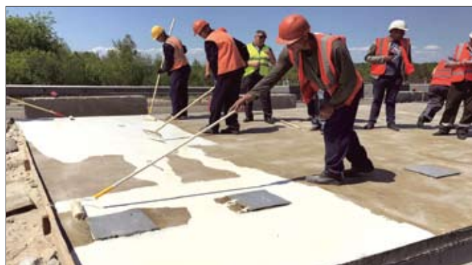
Ремонт моста через падь Поплавскую на км 1499+723 автомобильной дороги Р-297 «Амур» Чита – Невер – Свободный – Архара – Биробиджан – Хабаровск, Амурская область
