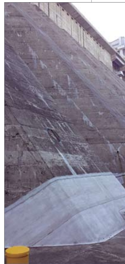
Защита бетонного покрытия турбинных водостоков на Красноярской ГЭС
