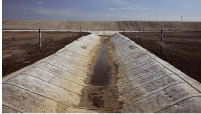
Возведение водоотводящих каналов в г. Мирный, Якутия
