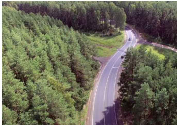
Ярославская агломерация, автодорога Лесные поляны — Ярославль
