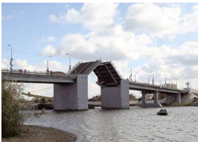
Астраханская агломерация, мост через р. Кривая Болда (капитальный ремонт моста)
