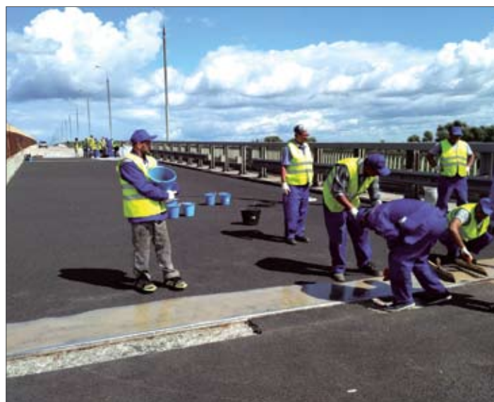
Ремонтные работы на мосту через р. Оку в Рязани
