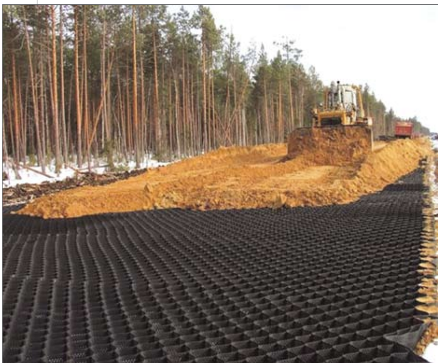
Рис. 1. Строительство промышленной дороги с использованием пространственной георешетки, заполненной песком, в качестве покрытия переходного типа
