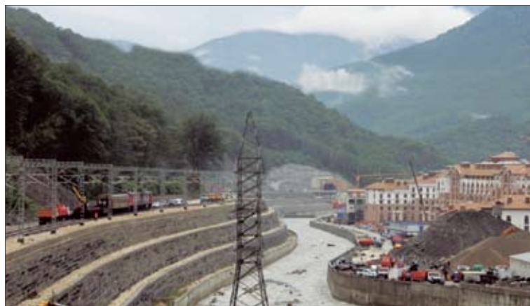
Строительство совмещенной дороги Адлер — горноклиматический курорт «Альпика-Сервис»
