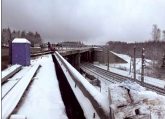
Рис. 5. Открылок опоры ОК1 правого путепровода
