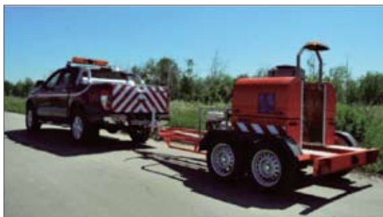
Регистрация чаши динамических прогибов на поверхности покрытия
