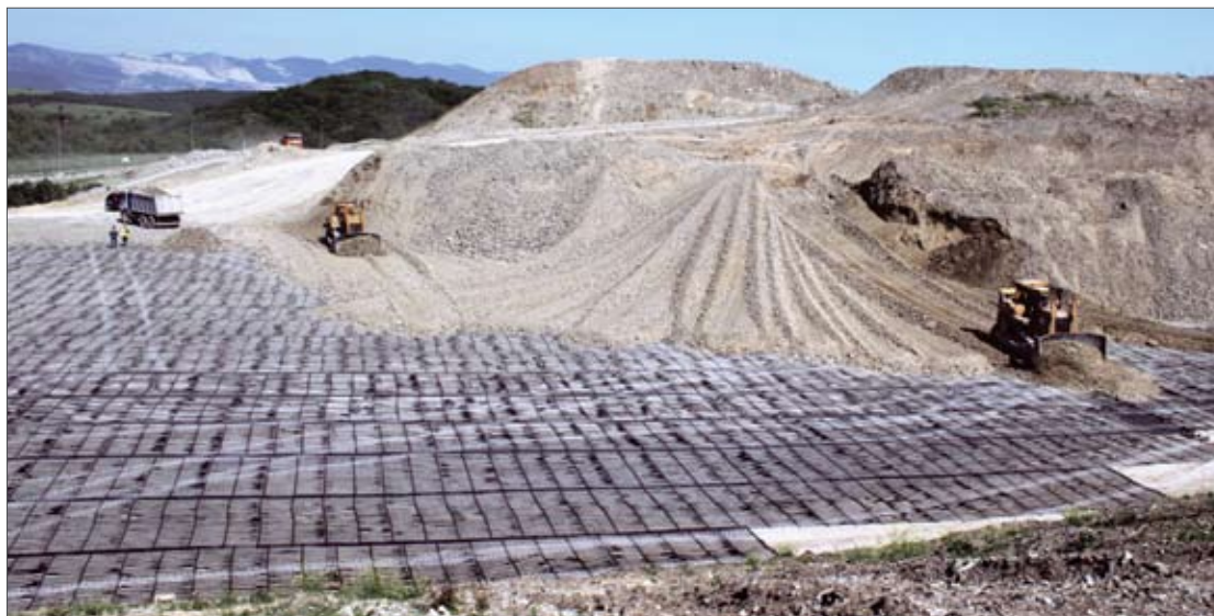
Строительство резервуарного парка Каспийского трубопроводного консорциума
