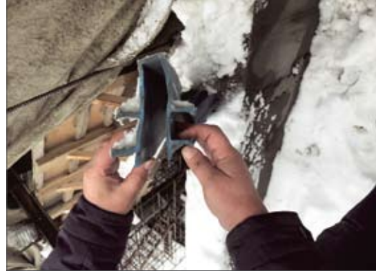
Рис. 7. Гидроизоляционная шпонка открылка
