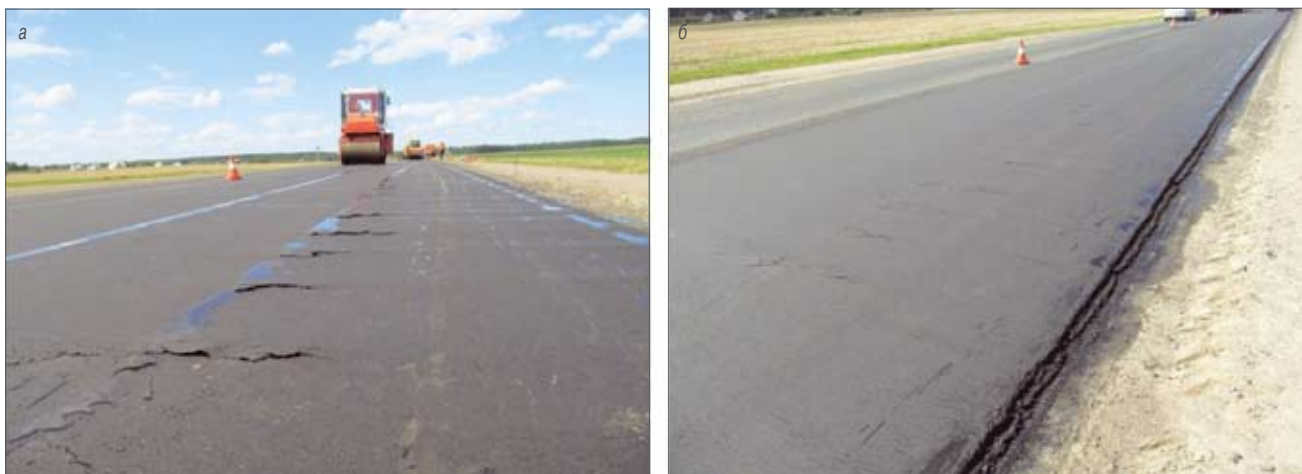
Рис. 4. Состояние поверхности слоя асфальтобетона после укладки (а) и уплотнения слоя (б)
