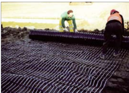
Армирование дамбы искусственного пруда для горнолыжного комплекса «Альпика-Сервис»
