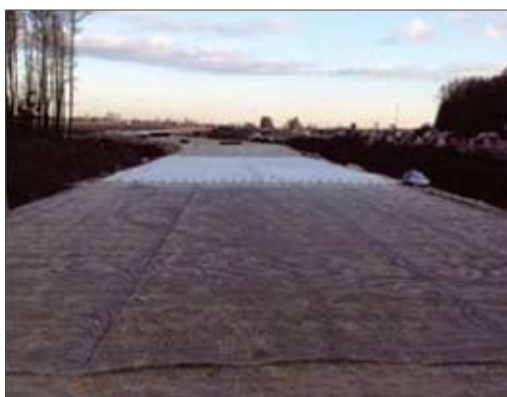
Полигон испытания геосинтетических материалов армирования слоев оснований дорожных одежд
