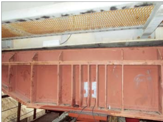
Размещение тензодатчиков на перекаточном устройстве
