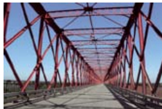
МОСТОВЫЕ МЕТАЛЛОКОНСТРУКЦИИ, ПЕШЕХОДНЫЕ ПЕРЕХОДЫ, ПУТЕПРОВОДЫ
