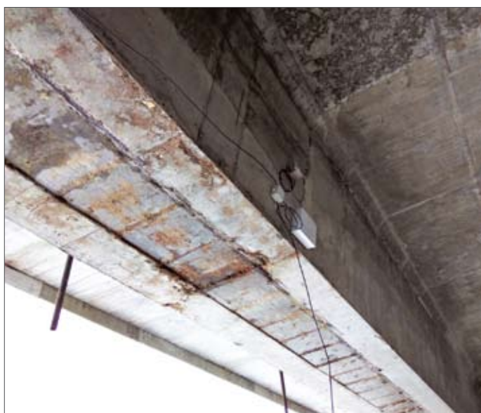
Мониторинг строящегося моста ЦКАД через р. Москву
