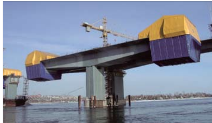
Процесс сооружения пролетного строения из монолитного железобетона моста через р. Ангару в г. Иркутске, 2004 г.
