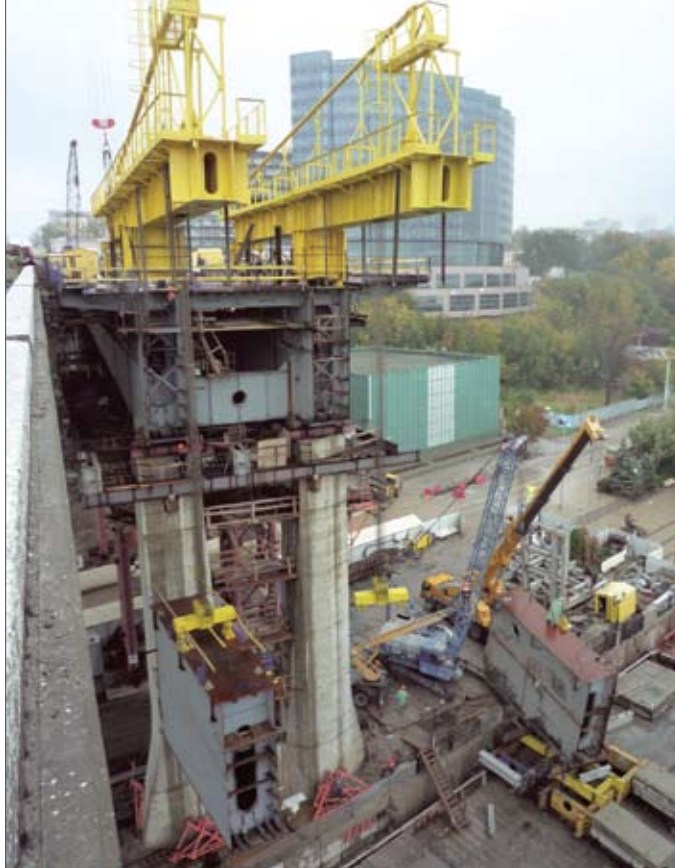
Рис. 4. Навесной монтаж коробчатого блока главной балки с цельносварным стыком. Ворошиловский мост в Ростове-на-Дону
