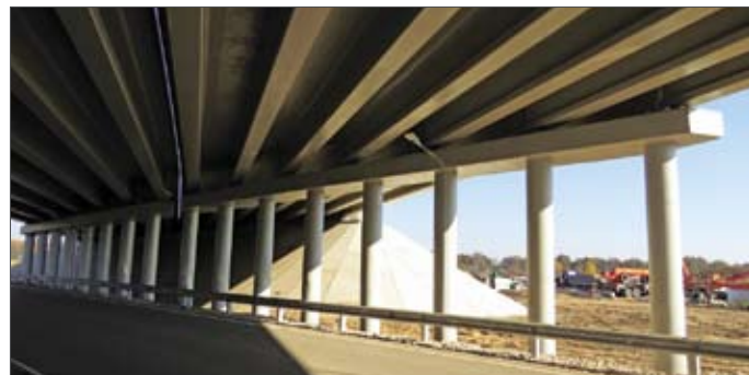
Пролетные строения путепровода из сборных балок заводского изготовления, г. Калуга, 2018 г.
