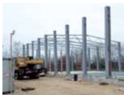
НЕСУЩИЕ КОЛОННЫ, БАЛКИ, ПРОГОНЫ
