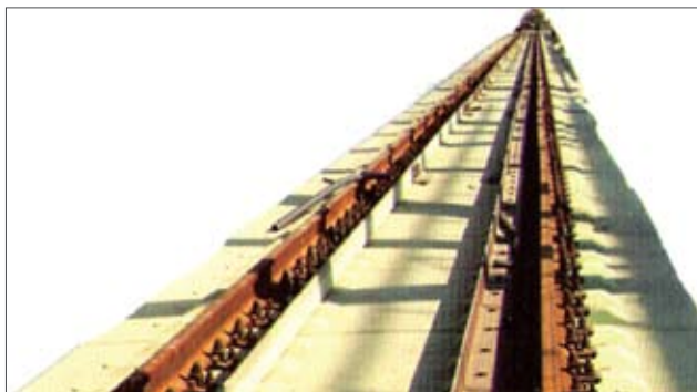
Крепление уходящего под воду пролета и опускной части железнодорожного моста в сейсмически активной зоне
