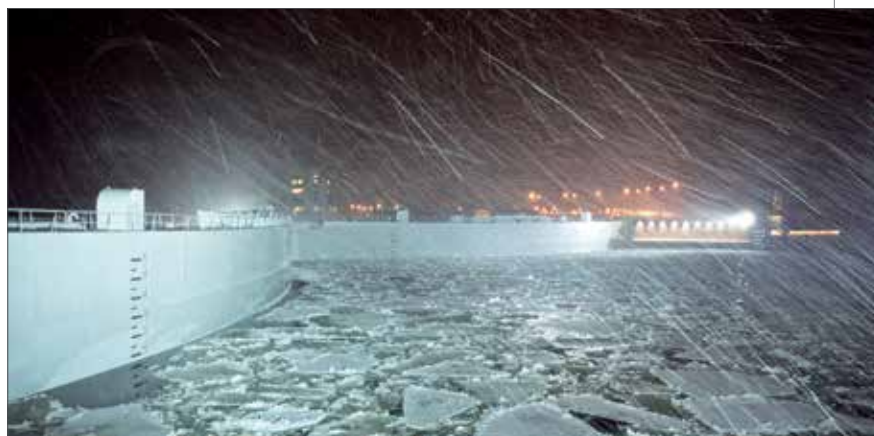
Рис. 2. Предотвращение наводнения 13 января 2015 года. Затвор судопропускного сооружения С-1 в положении «закрыто»
