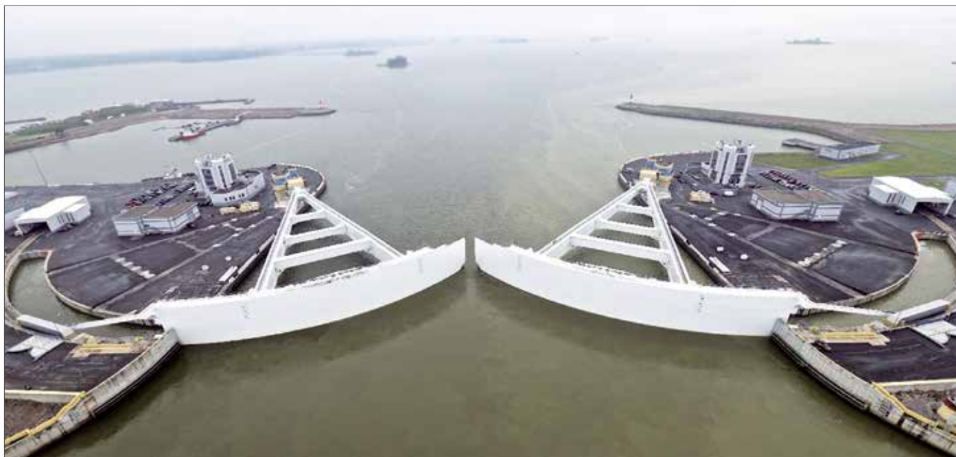
Рис. 5. Процесс закрытия затворов КЗС во время испытаний
