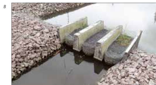
Рис. 7. Гидробиологическая площадка (ГБП) в составе двух прудов с усиленной защитой от нефтепродуктов: а – схема: 1 – основной пруд ГБП с высшей водной растительностью; 2 – буферный пруд; 3 – природный сорбент; 4 – фильтрующая кассета; 5 – подводящий лоток; 6 – соединительный лоток; 7 – боны из сорбирующего нефтепродукты материала; б – вид сооружения (пример); в – фильтрующие кассеты
