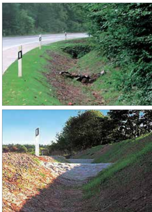
Рис. 3. Кюветы, обустроенные порогами
