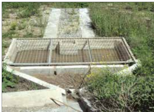
Рис. 10. Простейшие очистные сооружения (пример)
