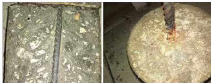
Рис. 2. Определение защитных свойств бетона с добавкой «Пенетрон Адмикс» по отношению к стальной арматуре
