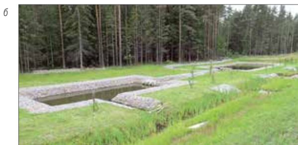
Рис. 7. Гидробиологическая площадка (ГБП) в составе двух прудов с усиленной защитой от нефтепродуктов: а – схема: 1 – основной пруд ГБП с высшей водной растительностью; 2 – буферный пруд; 3 – природный сорбент; 4 – фильтрующая кассета; 5 – подводящий лоток; 6 – соединительный лоток; 7 – боны из сорбирующего нефтепродукты материала; б – вид сооружения (пример); в – фильтрующие кассеты
