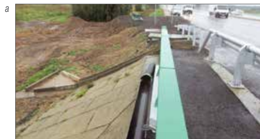
Рис. 9. Примеры неэффективных очистных сооружений: а – находится за пределами водоохранной зоны, но перед мостами запроектированы водосбросы; б – при наличии очистных сооружений сток в них не попадает
