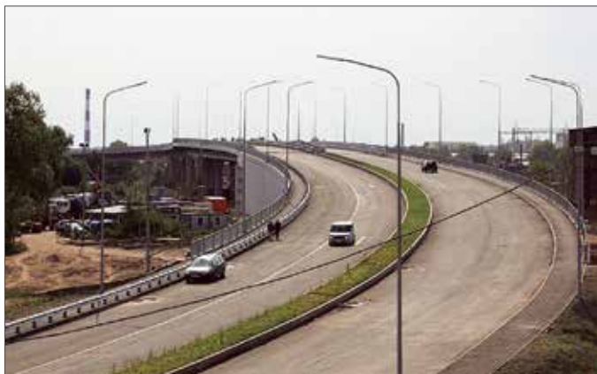
Автодорожный путепровод через железную дорогу в г. Великие Луки Псковской области
