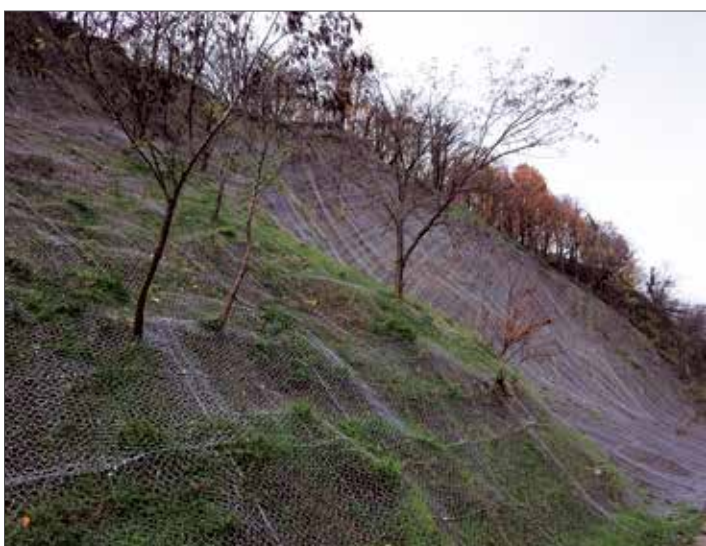
Рис. 5. Экологичное использование Стилгрид® на А-147
