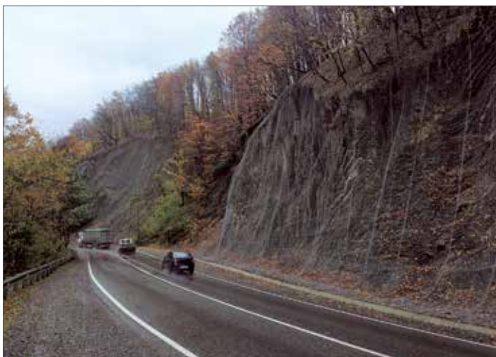
Рис. 4. Противокаменная драпировка вдоль А-147
