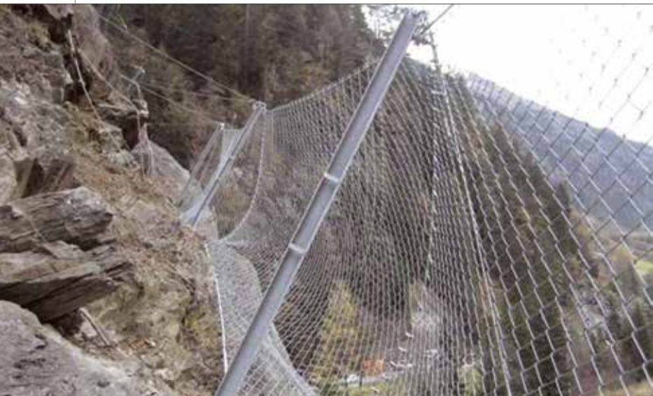
Рис. 3. Смонтированные гибкие улавливающие противообвальные сооружения
