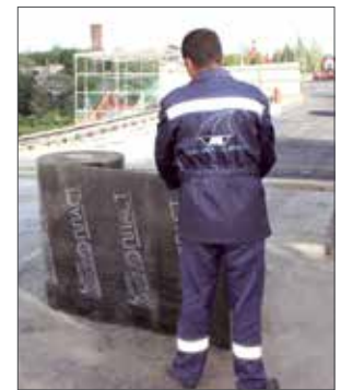
Устройство гидроизоляции с применением рулонного наплавляемого материала «Мостопласт» (Свидетельство №2015700666)
