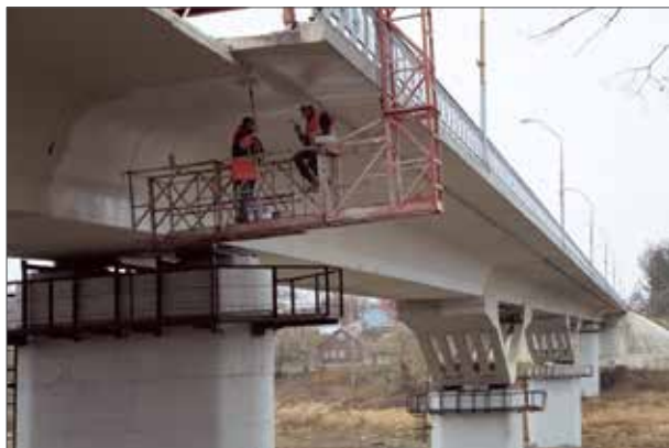
Окраска опор и пролетного строения
