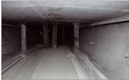
4 пучка канатов в углах коробки
