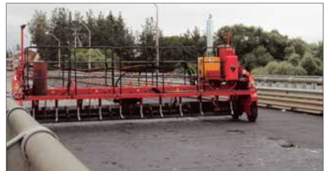
Устройство покрытия из литого асфальтобетона «МОСТЛАБ» (Патент №2483152, Свидетельство №517373)
