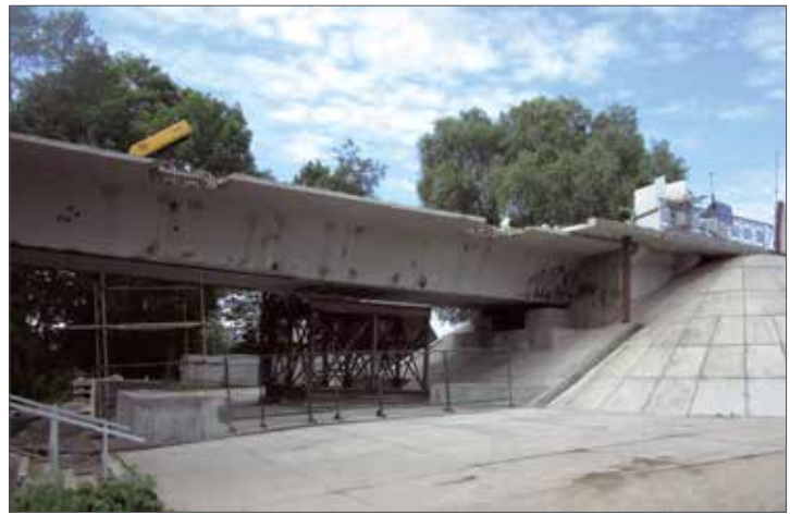
Демонтаж временных опор
