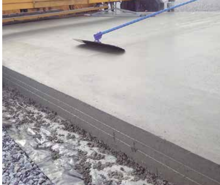
Замена искусственного покрытия аэропорта Пулково
