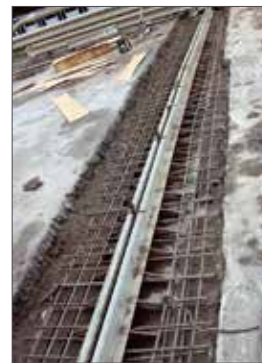
Конструкция деформационного шва СК-80 (Патент №83081, №90788, №94634)
