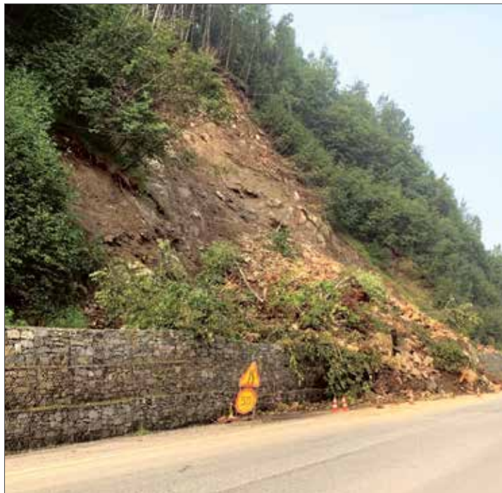
Рис. 10. Гравитационная камнеулавливающая стена в действии
