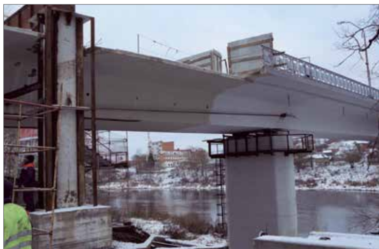
Временное усиление пролетного строения перед подъёмкой
