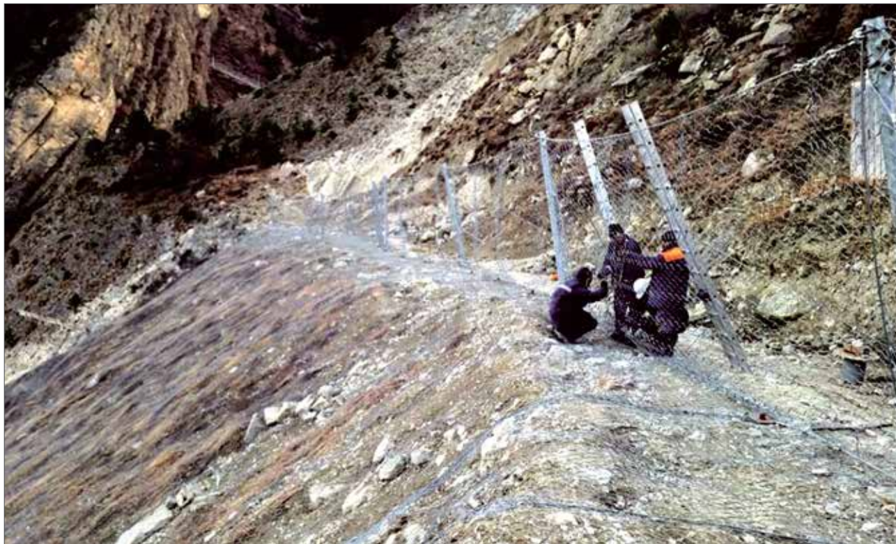
Рис. 9. Установка камнеулавливающего барьера, Гоцатлинская ГЭС
