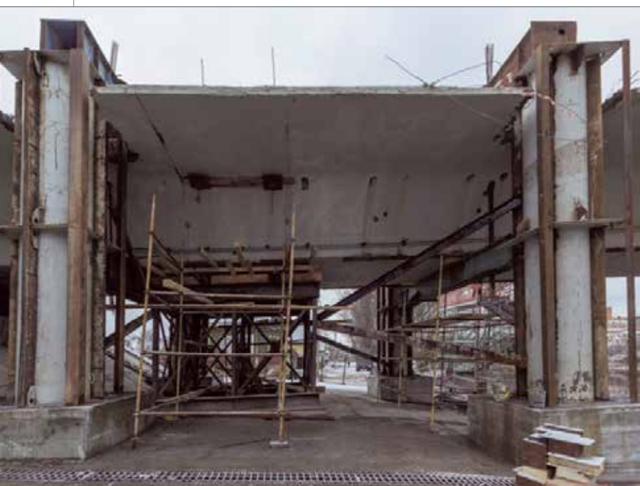
Общий вид пролетного строения после подъёмки
