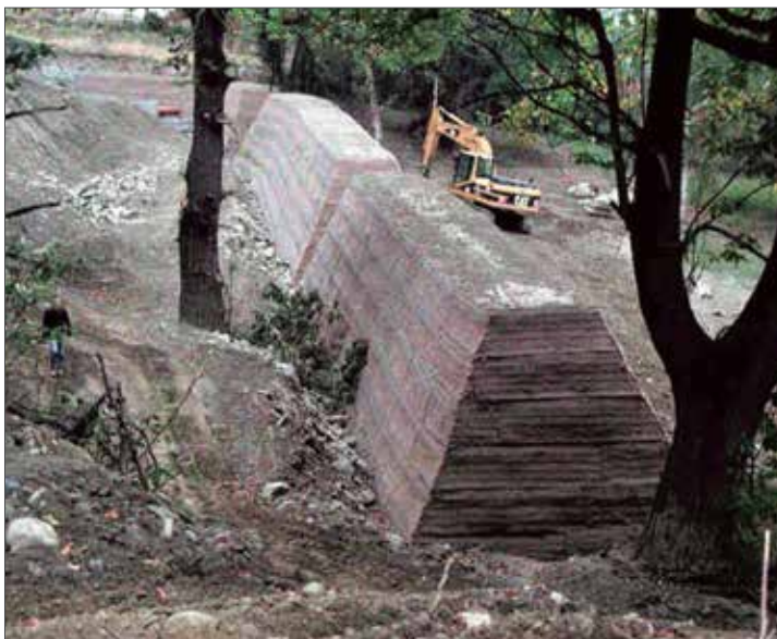
Рис. 11. Армогрунтовая камнеулавливающая насыпь по технологии «Зеленый Террамеш®»
