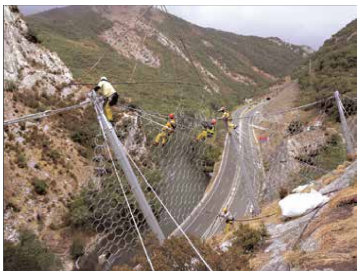
Рис. 6. Установка камнеулавливающего барьера
