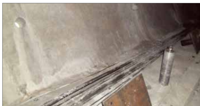
Бурение отверстий в блоках
