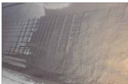
Нанесение торкрет бетона
