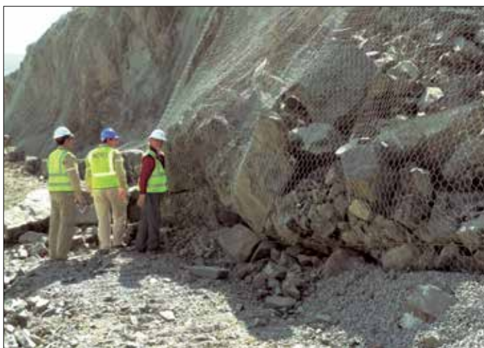
Рис. 2. «Карман» с камнями у подножия склона
