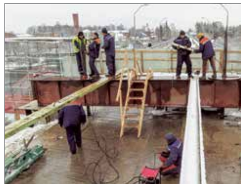
Установка канатов и домкратов для подъёмки
