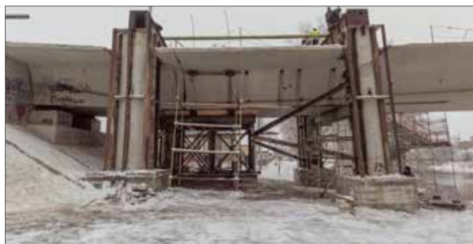
Установка специальных временных устройств для подъёмки
