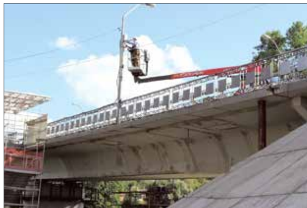
Установка камер видеонаблюдения
