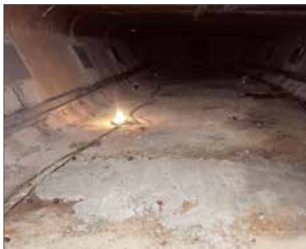
Установка балки усиления и шпенок внутри пролетного строения
