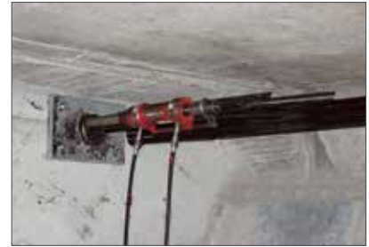
Усиление моста с использованием шпренгельной системы
