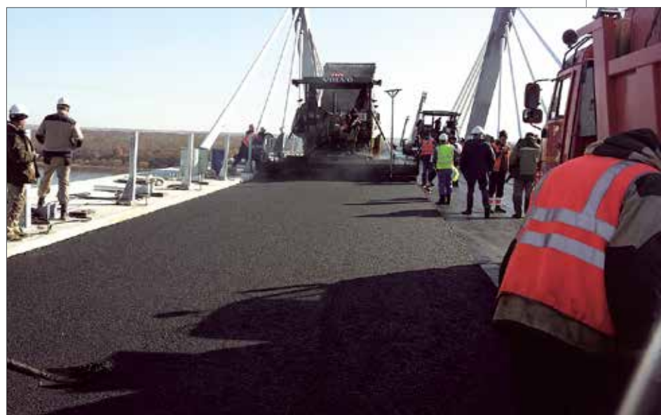
Рис. 3. Устройство асфальтобетонного покрытия дорожной одежды на ортотропных плитах проезжей части индивидуального проектирования с применением модификатора «Полиэпор-РП» на мостовом переходе через р. Амур Хэйхэ (КНР) — Благовещенск (РФ)
