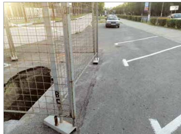
Обследование грунта на территории автомобильной стоянки
