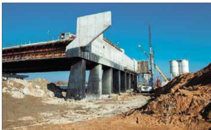
Путепровод над автомобильной дорогой М-10
