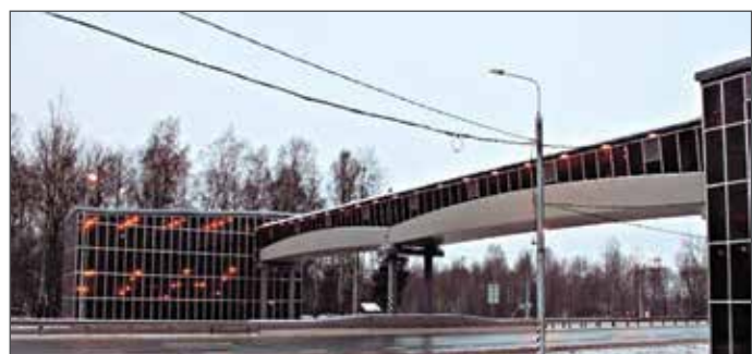
Монолитные цельнокомпозитные конструкции пролетных строений
