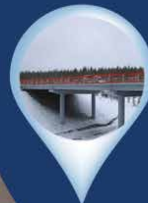
Защита мостовых сооружений
