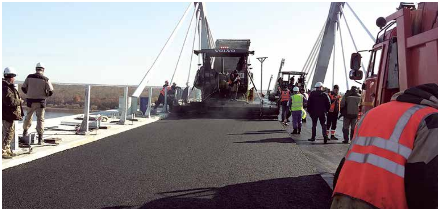
Рис. 3. Устройство асфальтобетонного покрытия дорожной одежды на ортотропных плитах проезжей части индивидуального проектирования с применением модификатора «Полиэпор-РП» на мостовом переходе через р. Амур Хэйхэ (КНР) – Благовещенск (РФ)
