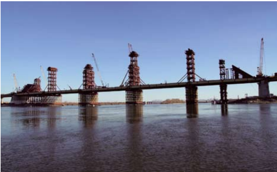
Общий вид на затяжку в период подготовки к надвигке арки моста
