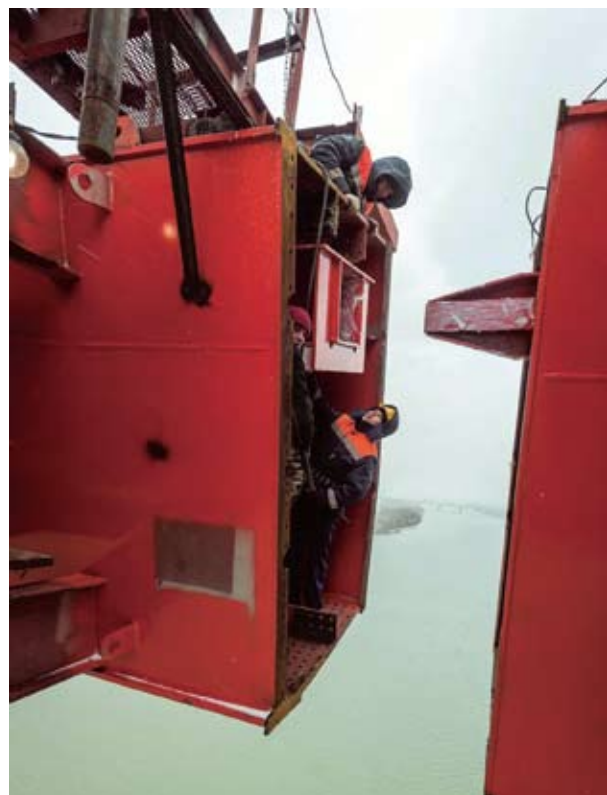
Рис. 9. Центрирующее устройство
