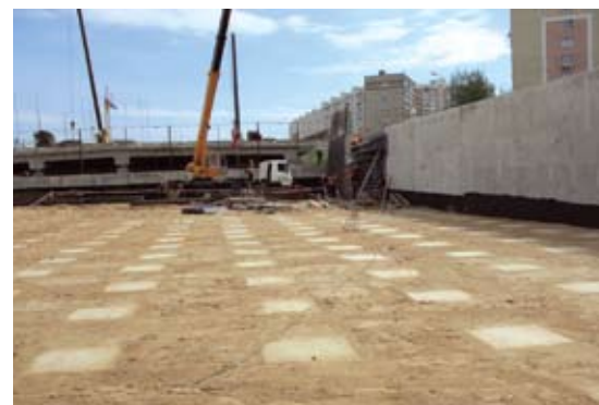
Рис. 8. Усиление слабого основания с помощью свайного поля
