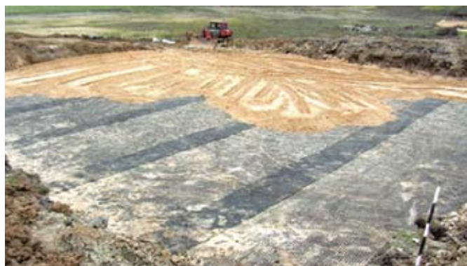
Рис. 4. Противокарстовые мероприятия на км 13+600 автодороги «Павлово-Сосновское-Лесуново-Мухтолово-Саконы» в Сосновском районе Нижегородской области
