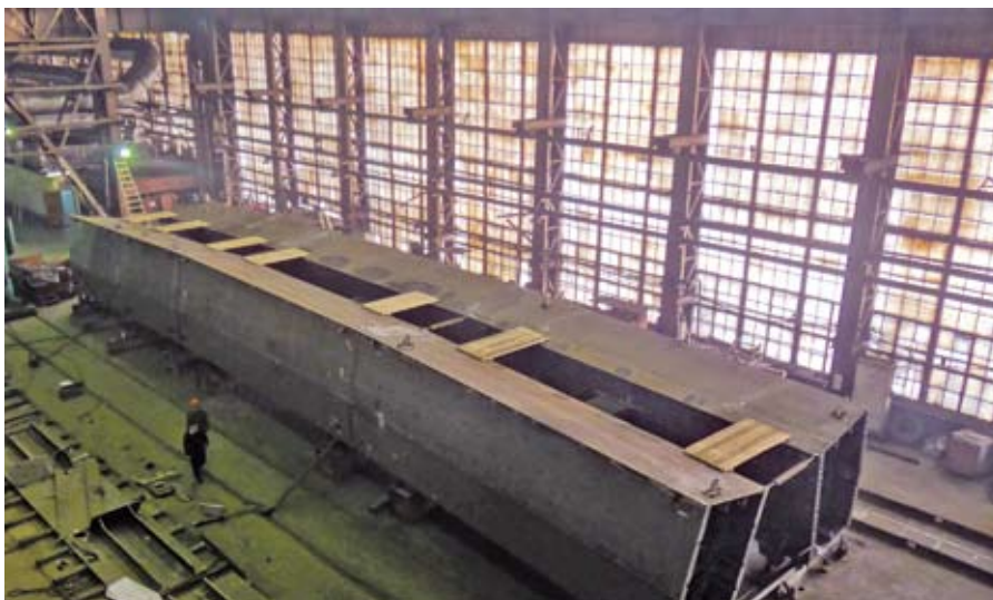
Рис. 8. Контрольная сборка восьми блоков на заводе
