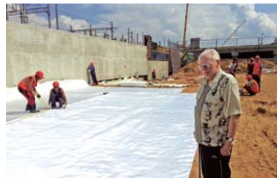
Рис. 9. Укладка геосинтетики. Научное руководство строительства — филиал ОАО ЦНИИС НИЦ «Мосты» (А.Д. Соколов)
