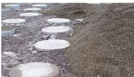
Рис. 5. Армирование основания насыпи участка шоссе Mossband Embankment, M6 Extension, Guardsmill, UK
