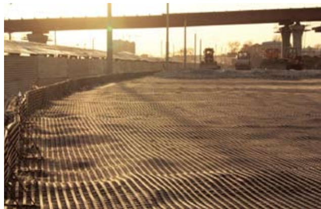
Монтаж гибкого свайного ростверка. Укладка армирующих элементов
