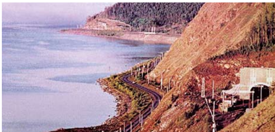
БАМ. Мысовый тоннель №3
