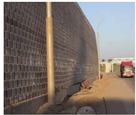
Внешний вид подпорной стены
