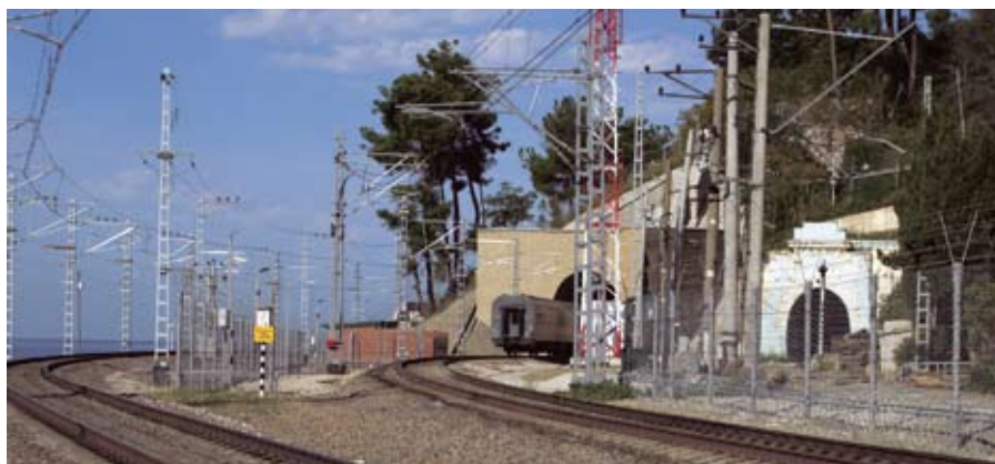
Южный портал тоннеля №8 бис на участке Сочи — Адлер СКЖД
