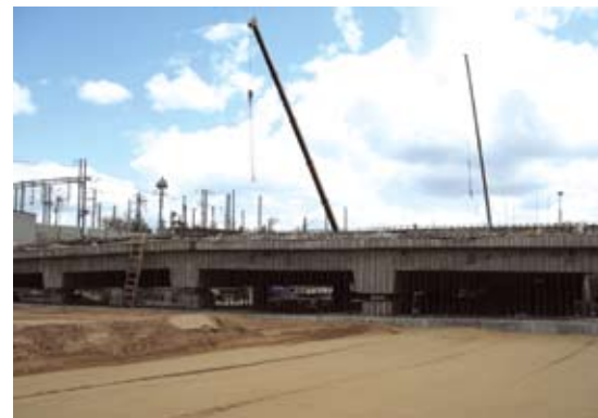
Рис. 7. Участок сопряжения насыпи с эстакадой №1
