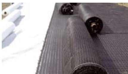
Рис. 5. Армирование основания насыпи участка шоссе Mossband Embankment, M6 Extension, Guardsmill, UK
