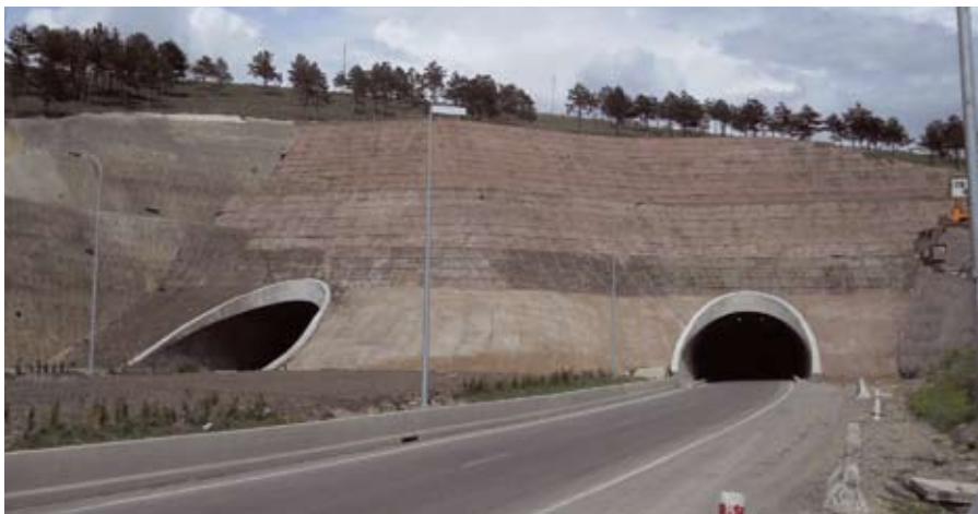
Тоннель на магистральной дороге Е60 «Шида — Картли» в Грузии
