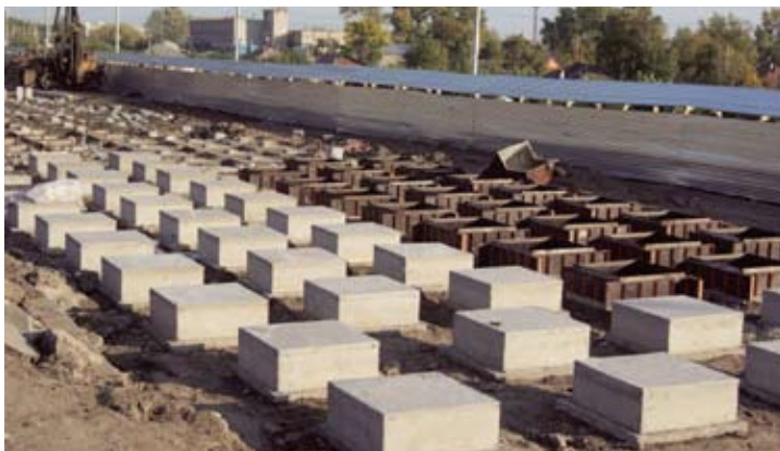
Монтаж свайного поля. Устройство монолитных ростверков
