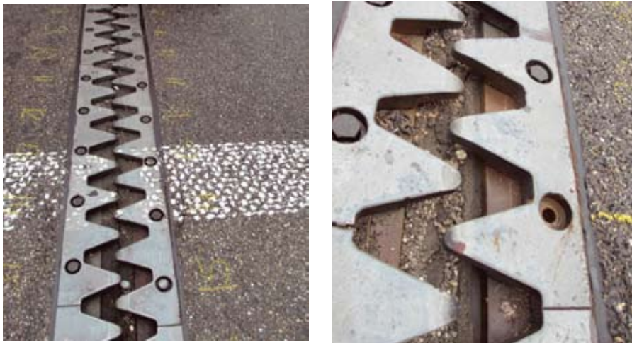
Рис. 2. Опасность ослабления болтового крепления
