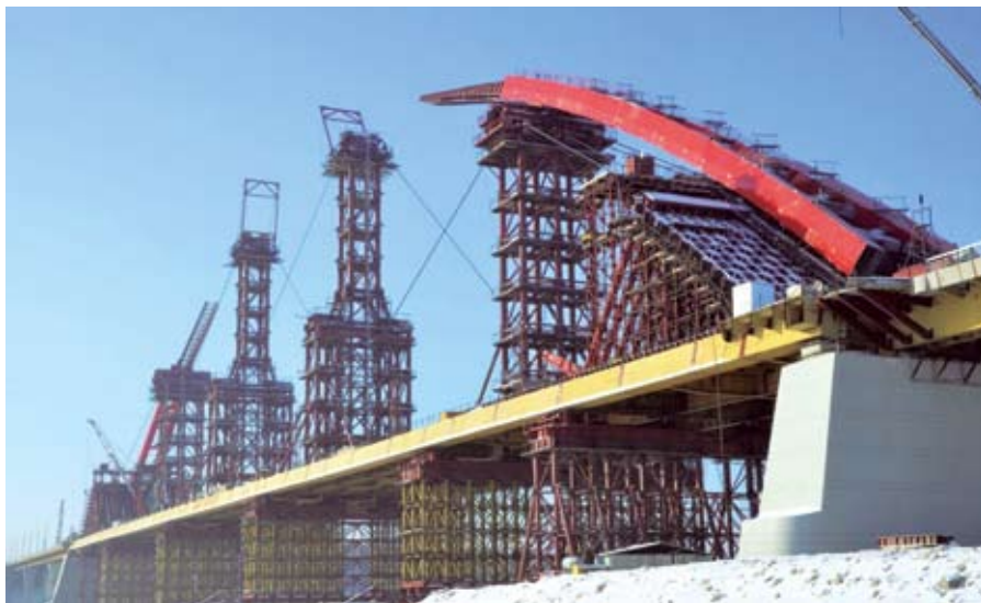
Общий вид на затяжку в период подготовки к надвигке арки моста
