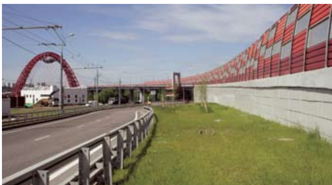
Рис. 3. Устройство армогрунтовой насыпи с вертикальными стенами из железобетонных сборных блоков на подходе к Живописному мосту, г. Москва
