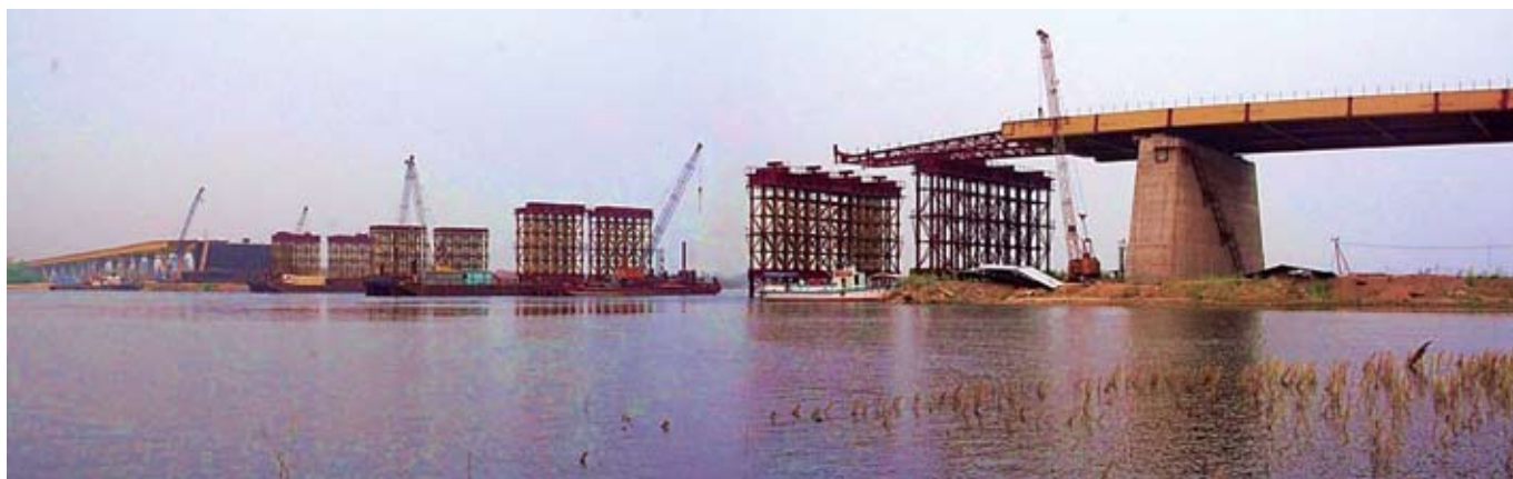
Затяжка пролетного строения арки монтировалась конвейерно-тыловой сборкой с продольной движкой с левого берега р. Обь в русло реки
