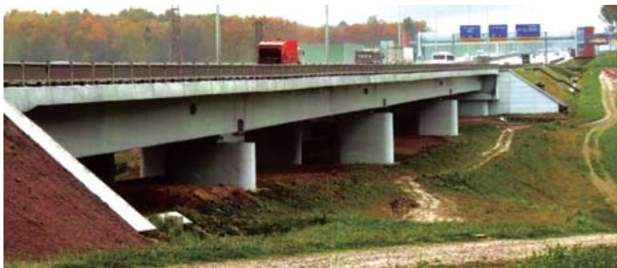
Рис. 6. Общий вид моста через р. Ликову на Киевском шоссе (2006 г.)
