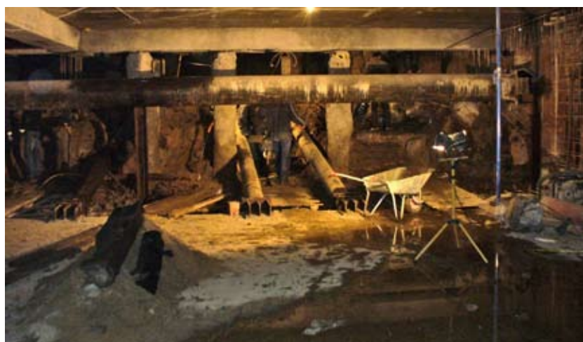
Рис. 6. Устройство подземного этажа способом top-down
