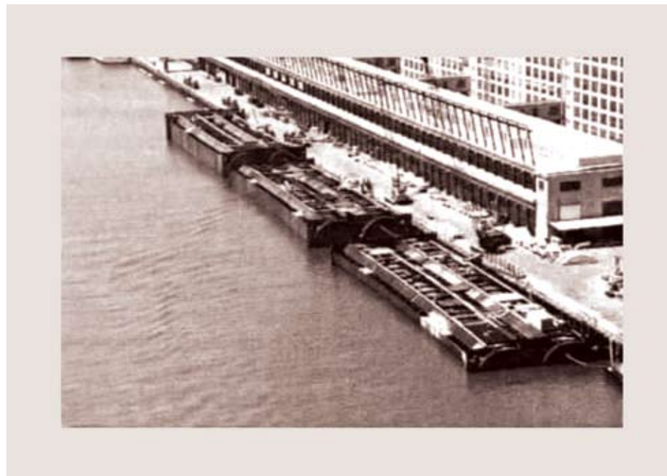
Рис. 8. Тоннель Ted Williams на причале (идет процесс бетонирования)
