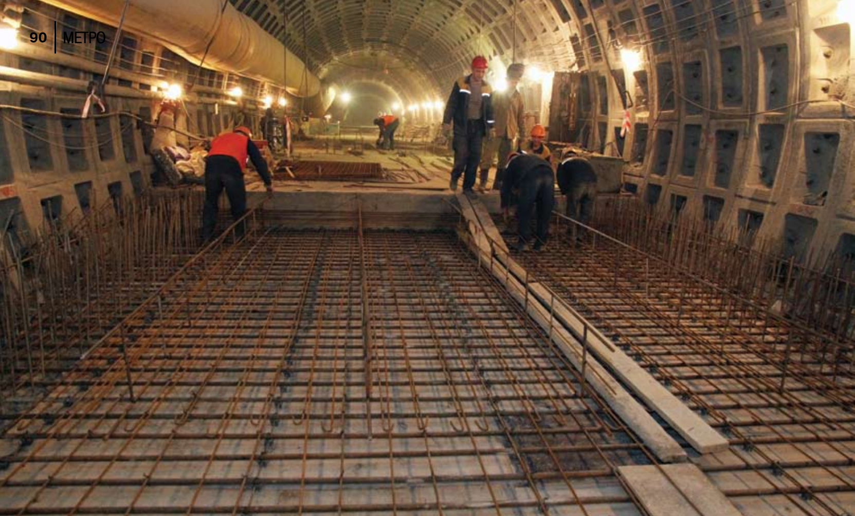
СМУ-13 готовит основание для установки траволаторов
