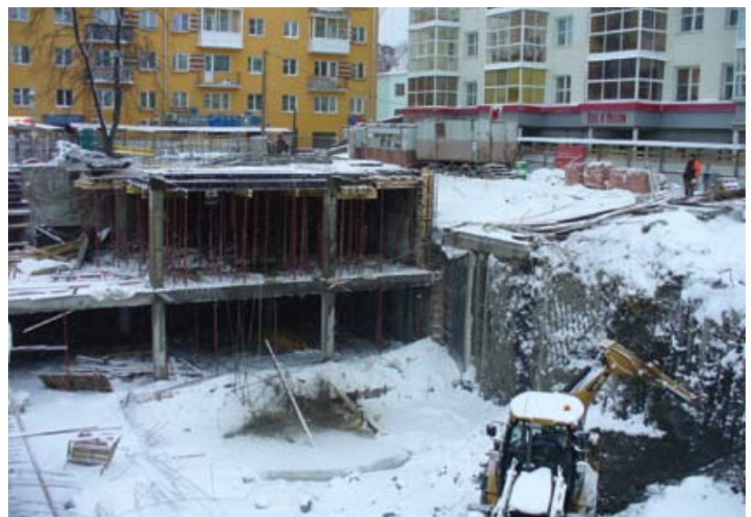
Рис. 3. Устройство подземного сооружения в Петрозаводске
