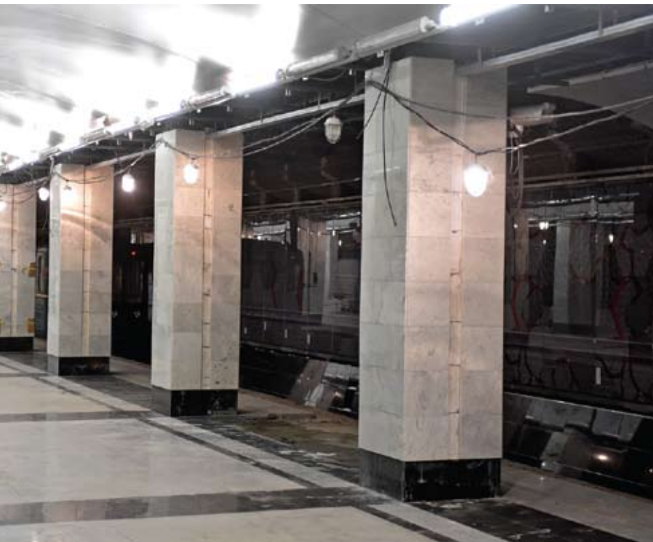
Строящаяся станция метро «Спартак»
