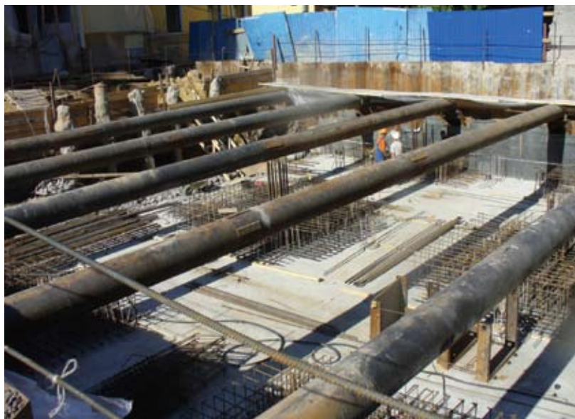
Рис. 5. Устройство подземного этажа открытым способом
