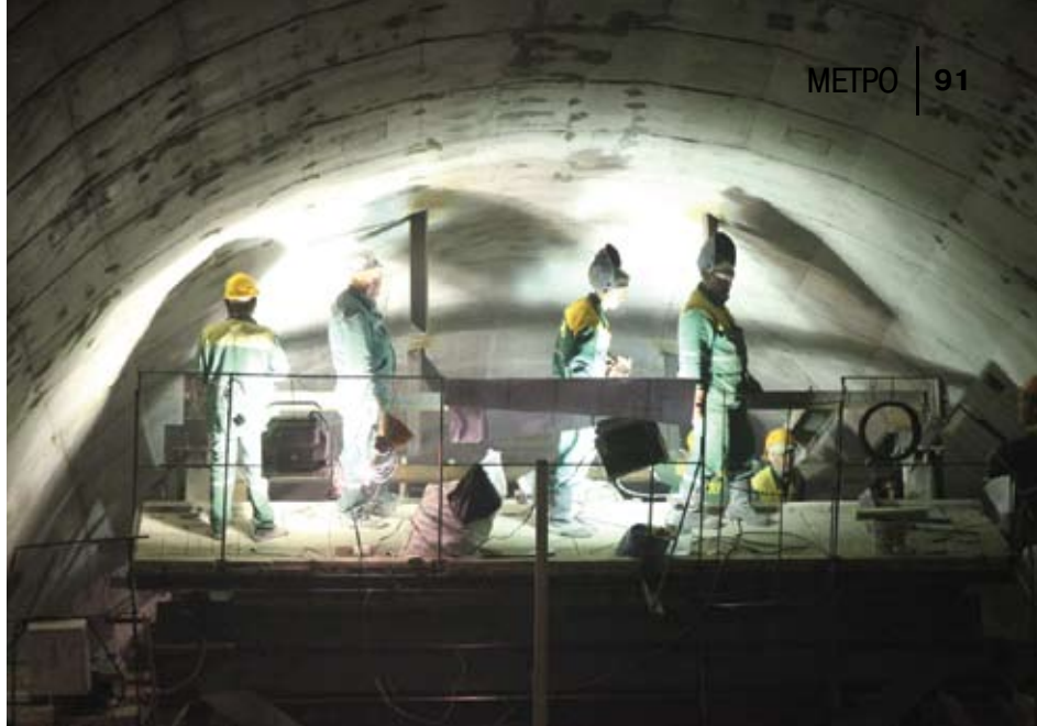
СМУ-11 ведет подготовку большого наклонного хода к монтажу эскалаторов
