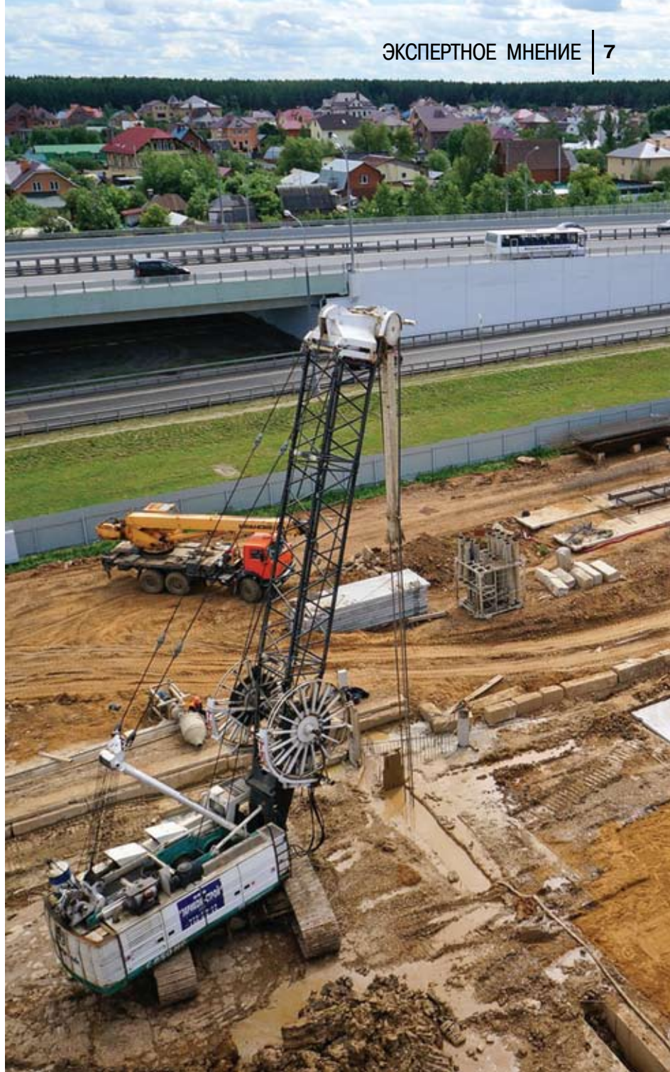
Строительство станции метро «Расказовка» Калининско-Солнцевской линии
