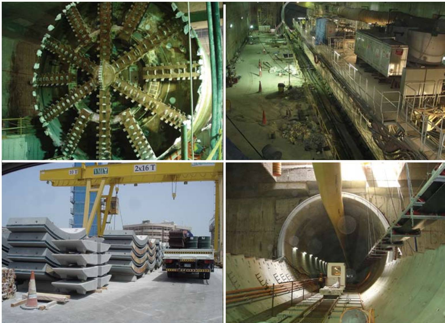
Рис. 7. Стартовый котлован для монтажа ТПКМ (в последующем здесь расположится станция метро)
