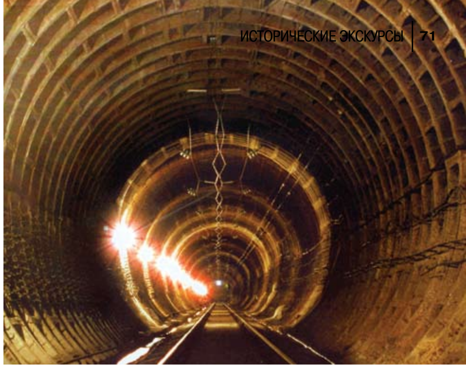
Чугунная обделка Северомуйского тоннеля
