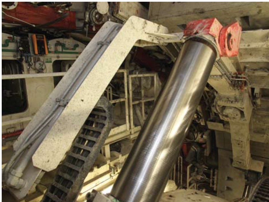
Установка блока обделки
