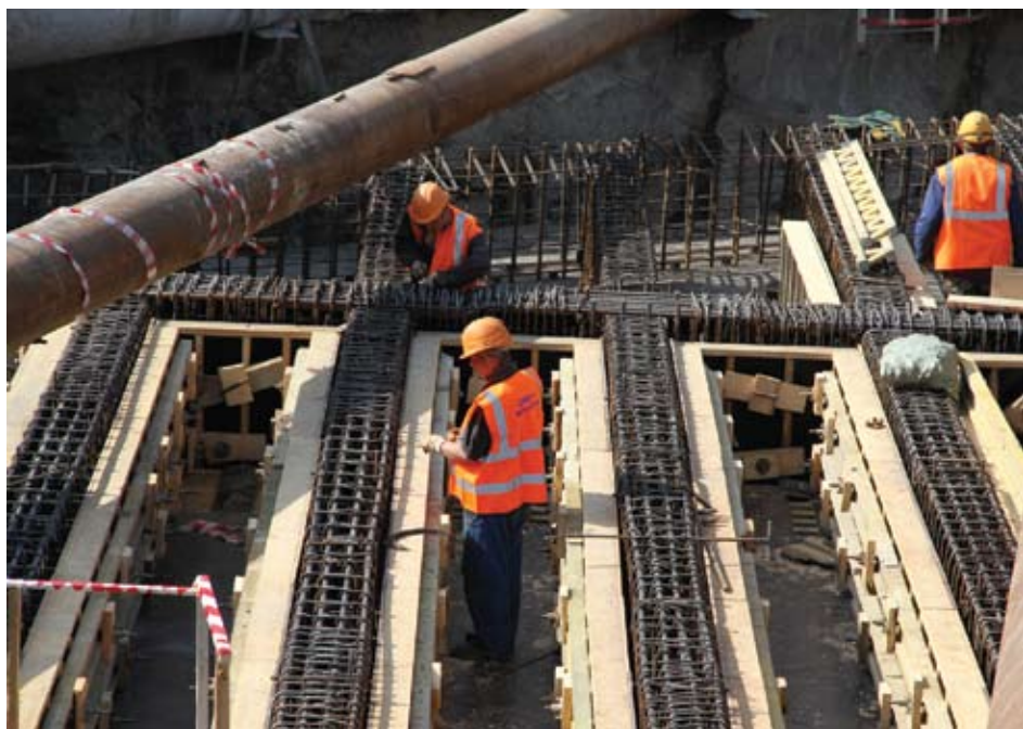
Арматурные работы в котловане
