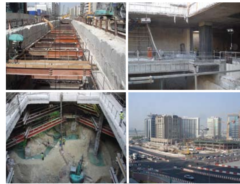
Рис. 6. Проходка заглубленных тоннелей открытым способом
