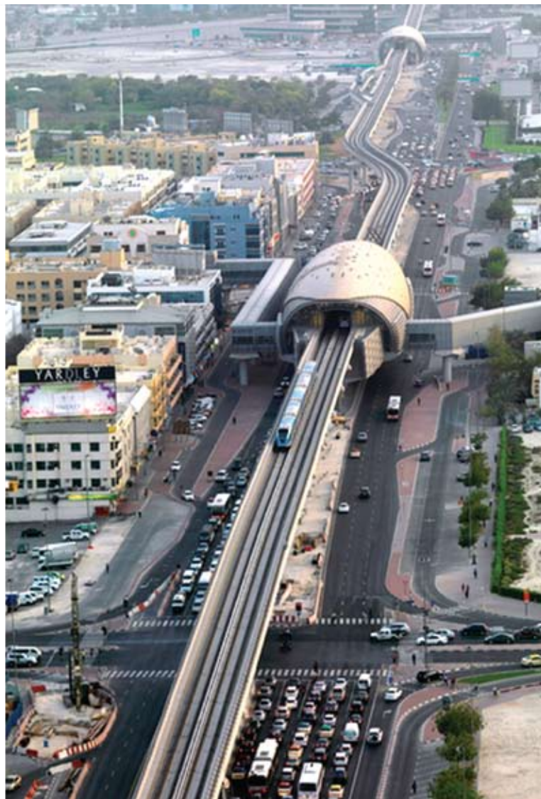
Рис. 8. Надземная линия метро на Sheikh Zaid Road в Дубае
