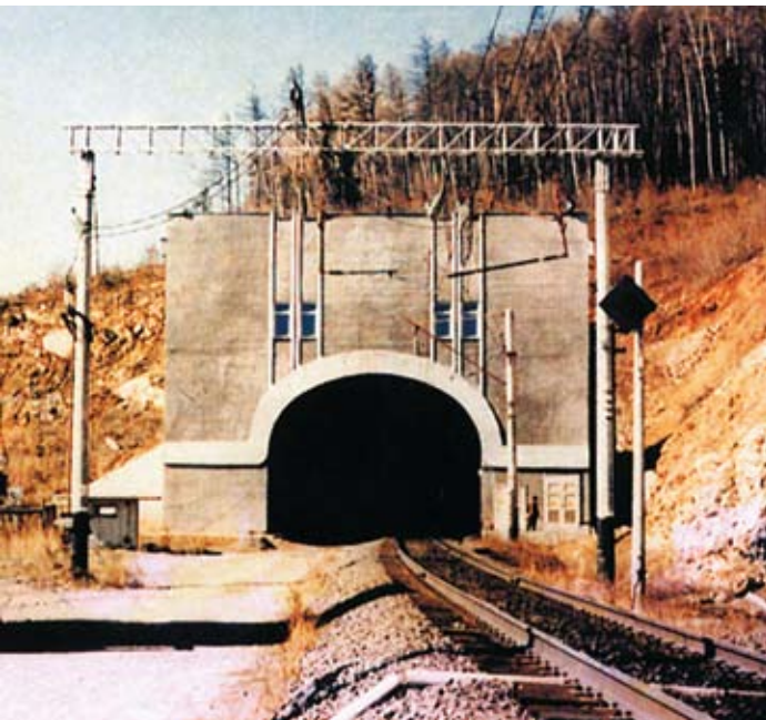
Третий мысовый тоннель
