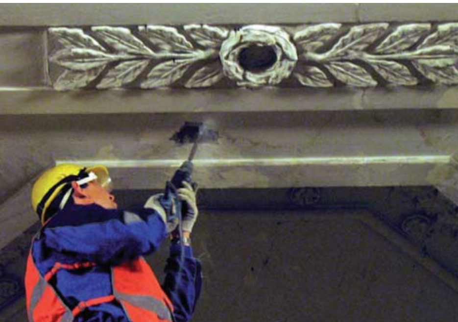
Обследование конструкций подвешенного потолка на станции «Автово»
