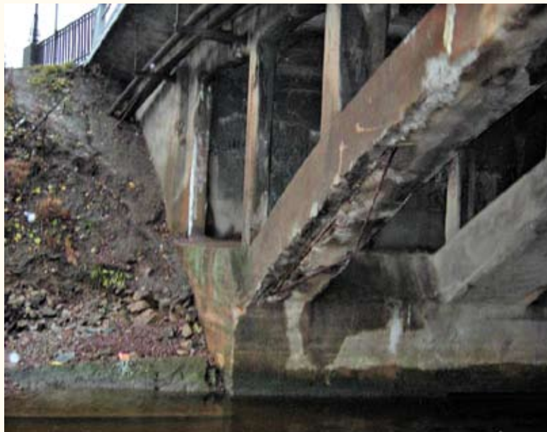
Рис. 45. Шлиссельбургский мост. Удар негабаритным водным транспортом
