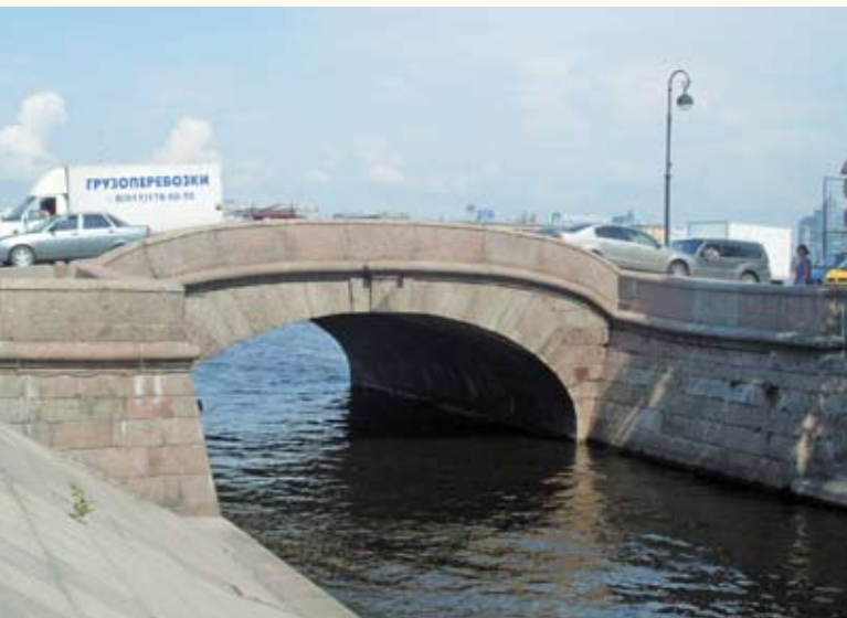
Рис. 7. Верхне-Лебяжий мост через Лебяжью канавку
