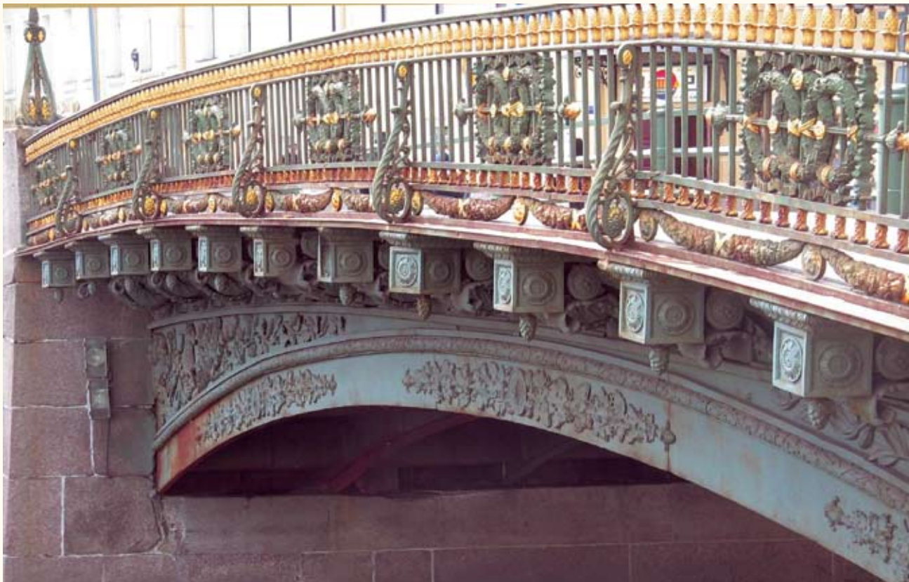
Рис.12. Большой Конюшенный мост через р. Мойку
