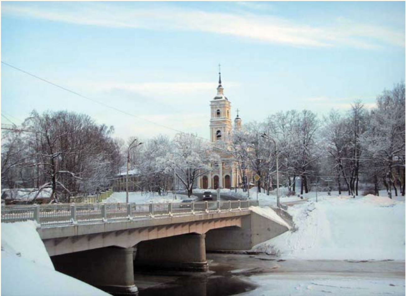
Рис. 24. Общий вид Большого Ильинского моста через реку Охту
