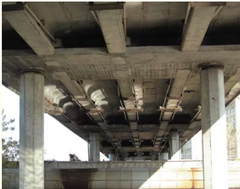
Рис. 46. Кронштадтский путепровод с элементами усиления
