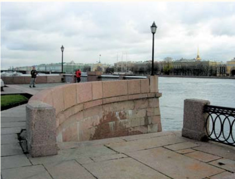
Рис. 3. Устой существовавшего наплавного Исаакиевского моста
