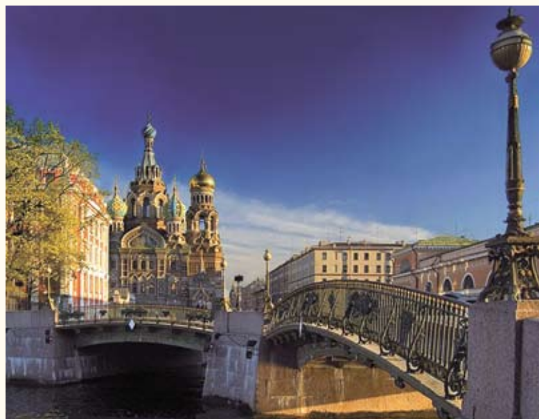
Рис. 11. Театральный (слева) и Мало-Конюшенный (справа) мосты через канал Грибоедова и р. Мойку соответственно
