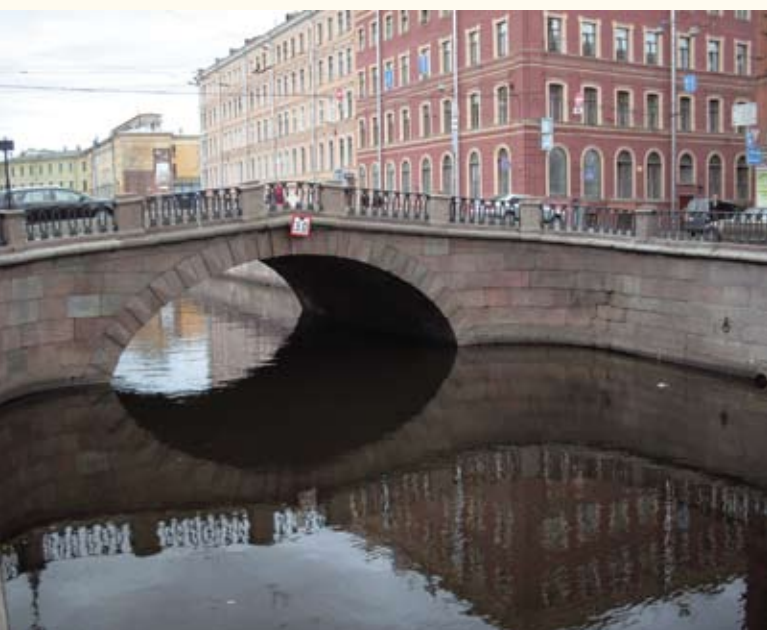
Рис. 8. Каменный мост через канал Грибоедова
