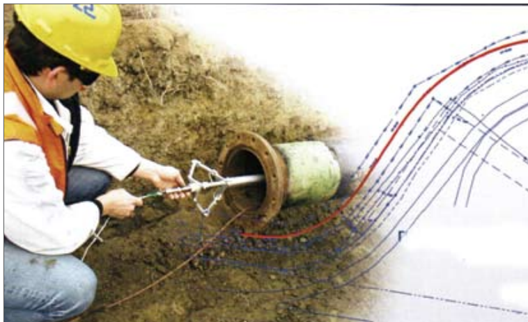
Протяжка прибора по трубе
