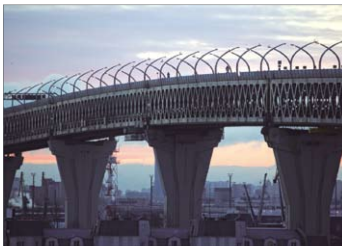
Двухъярусный мост через Морской канал
