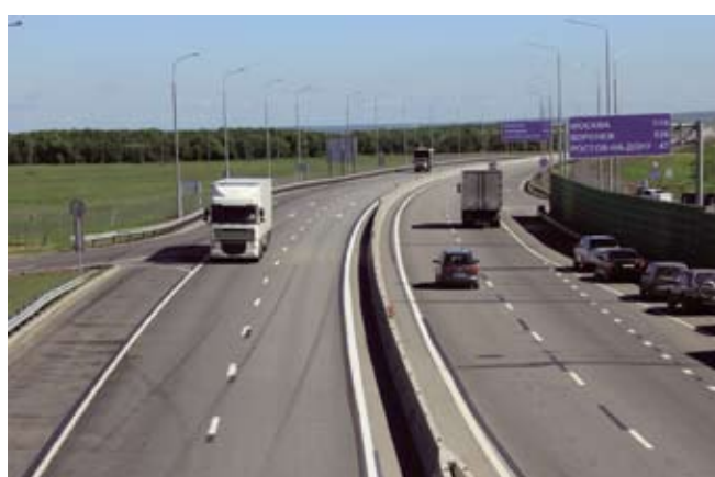
Автомобильная дорога М4 «Дон»
