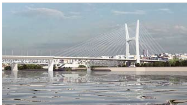
Мостовой переход через р. Обь в створе Ипподромской улицы в г. Новосибирске
