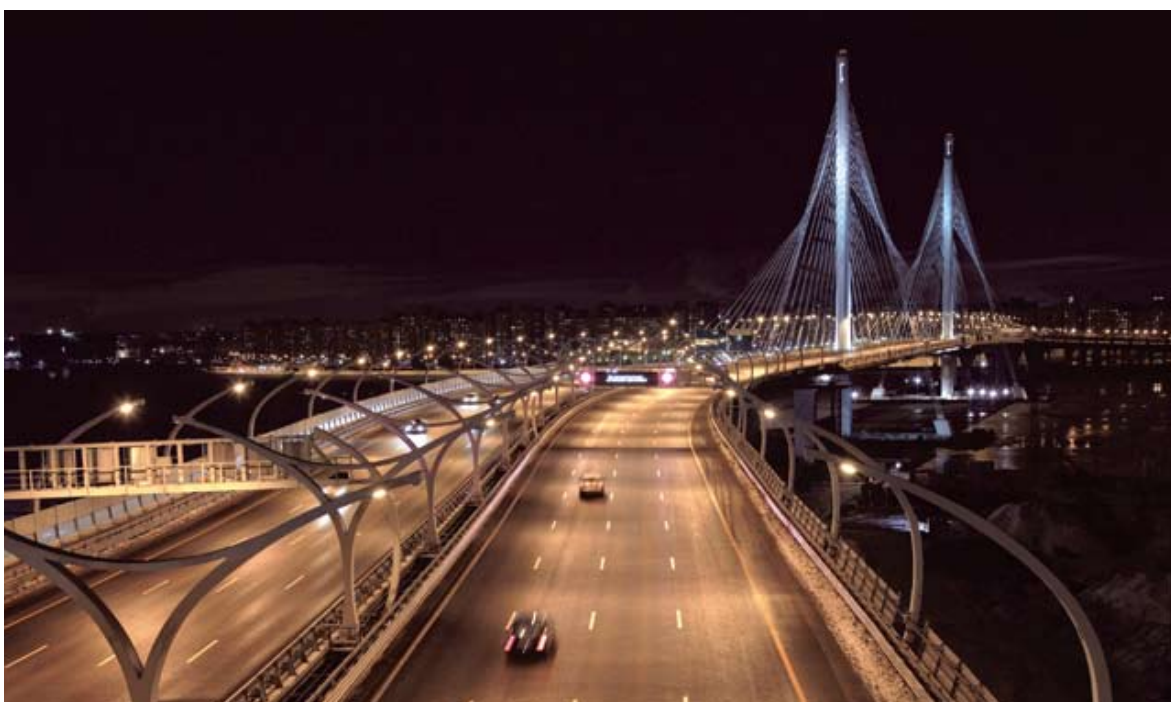
Мост через Петровский фарватер. ЗСД, Санкт-Петербург
