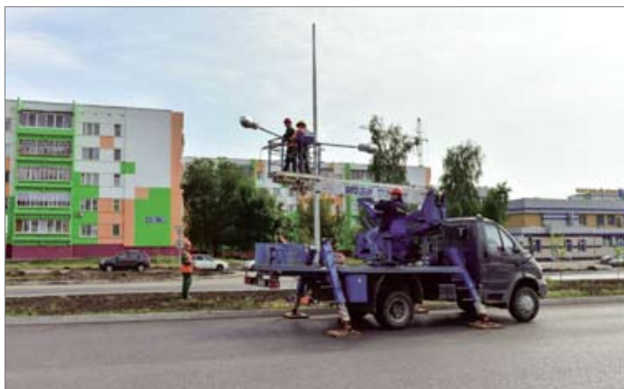
г. Набережные Челны, ремонт Московского проспекта
