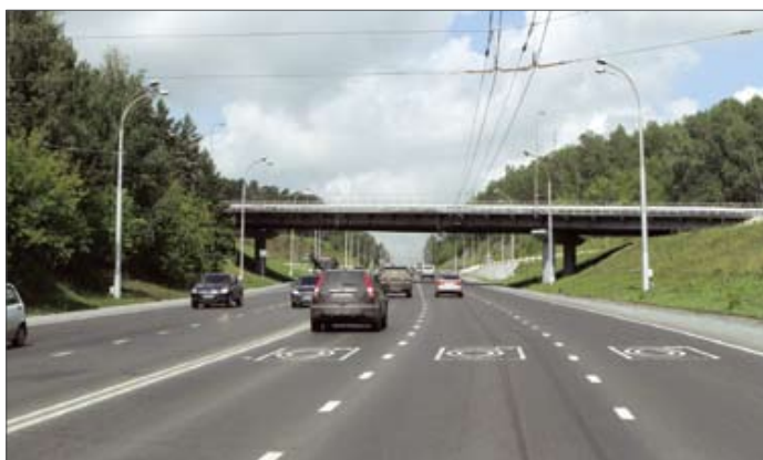
г. Кемерово, ул Терешковой до и после ремонта
