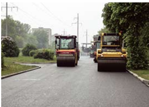
Ремонт дорог в Рязанской области
