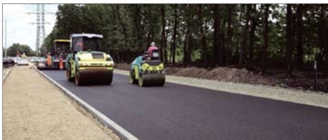
Ремонт дорог в Краснодарском крае
