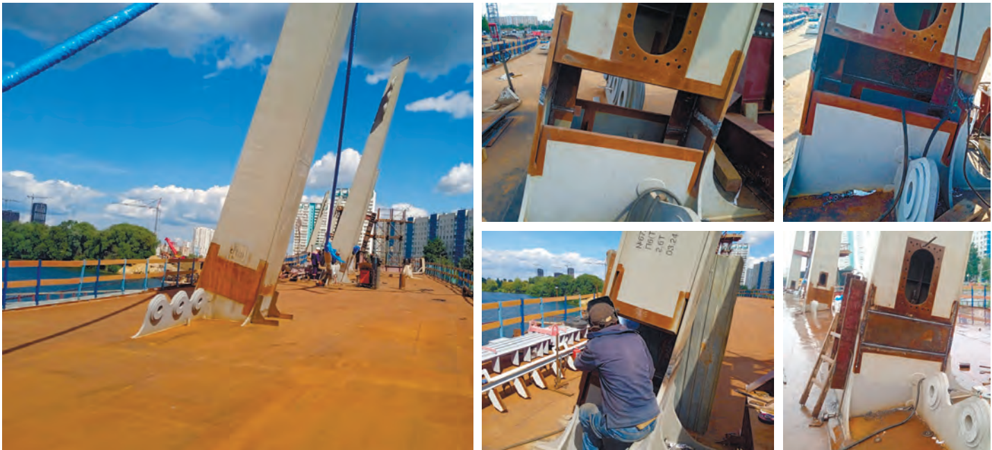
Рис. 10. Очередность сварки монтажных соединений пилонов
