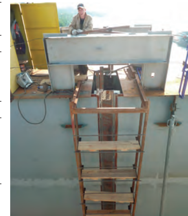
Рис. 5. Установка шпренгелей в стыке главной балки высотой 6 м. Ворошиловский мост через р. Дон в Ростове-на-Дону
