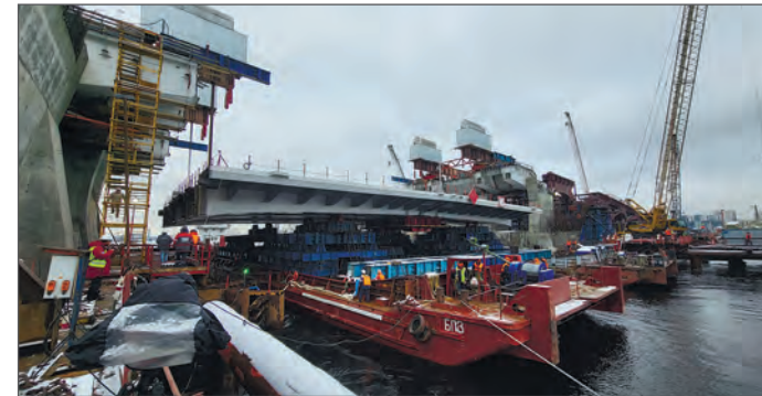
Рис. 5. Монтаж разводного пролетного строения
