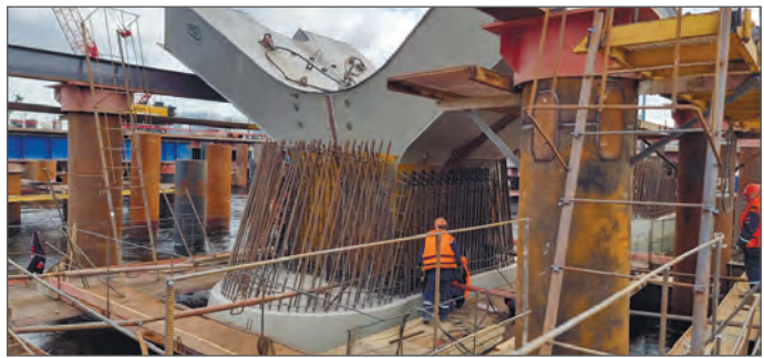
Рис. 6. Опорный блок арок перед бетонированием
