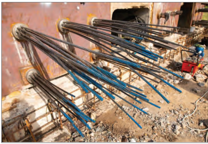
Преднапряжение пучков в коробке
