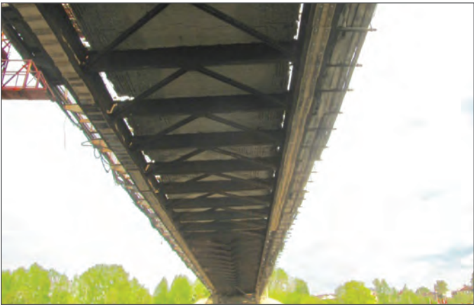
Стальная затяжка арочного металлического моста в виде железобетонного бруса
