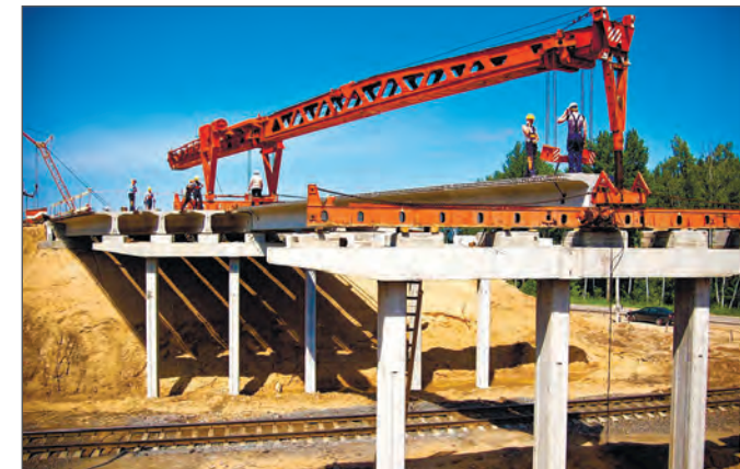
Консольно-шлюзовой кран для монтажа сборных балок на автодорожных мостах
