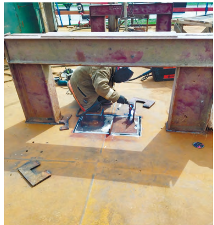
Рис. 9. Заварка проемов в листе настила верхней ортотропной плиты над вставкой в стенке коробчатой балки
