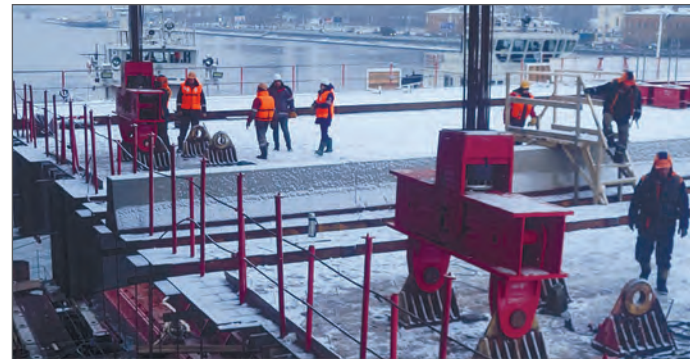
Рис. 5. Монтаж разводного пролетного строения
