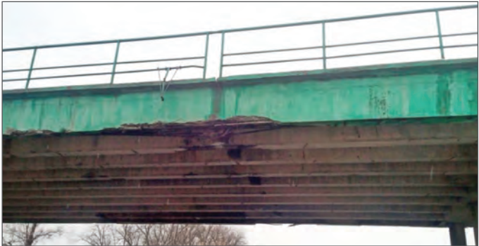
Повреждение балок путепровода наездом негабаритного автотранспорта на а/д Курск – Воронеж, 2017 г.
