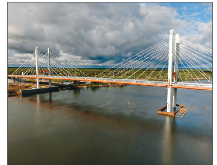
Вантовый мост через Оку
