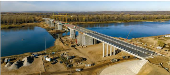
В ходе этой работы было выполнено шесть этапов надвизки пролетного строения моста. Несмотря на сложность работ опережение графика составило два месяца. На возведении мостового перехода одновременно было задействовано около 200 человек и 20 единиц техники.
