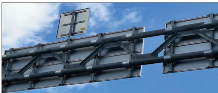
Композитные знаки, изготовленные по этой технологии, имеют ряд существенных преимуществ перед традиционно применяемой продукцией. Они более чем в три раза легче металлических аналогов, чем значительно снижаются нагрузки на рамные опоры. Знаки изготавливаются сегментами, это упрощает хранение, транспортировку и монтаж. При этом срок службы композитных материалов — более 50 лет.
