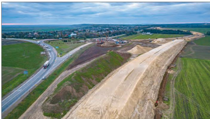
Протяженность новой четырехполосной федеральной трассы IB категории составит 118,6 км. Расчетная скорость движения – 120 км/ч. Ожидаемая расчетная интенсивность движения – 40 тыс. автомобилей в сутки.
