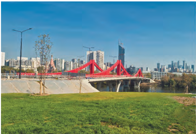
Обследование моста через р. Москва в створе ул. Мяснищева в г. Москве
