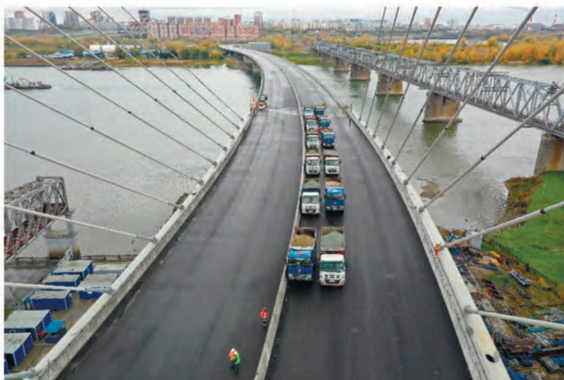
Испытания моста через р. Обь в г. Новосибирске
