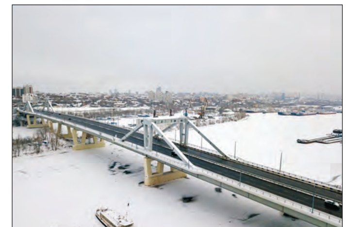
Рис. 5. Мост через реку Самару, общий вид после окончания строительства
