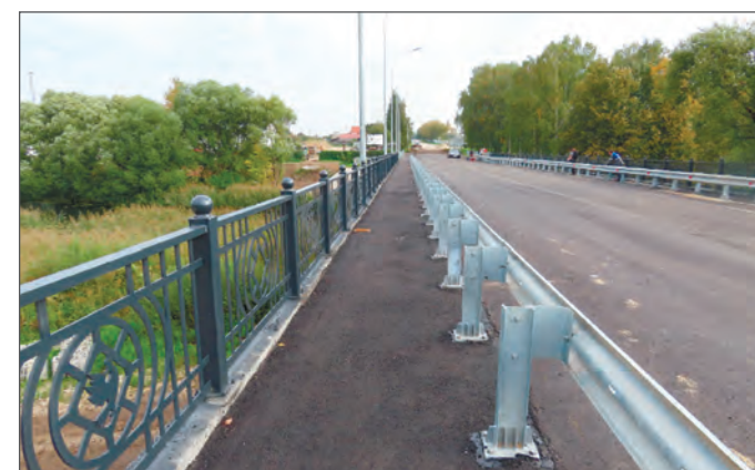
Фото 11. Вид тротуаров и проезжей части после реконструкции
