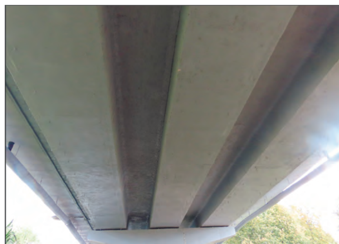
Фото 9. Вид на пролетное строение снизу после ремонта
