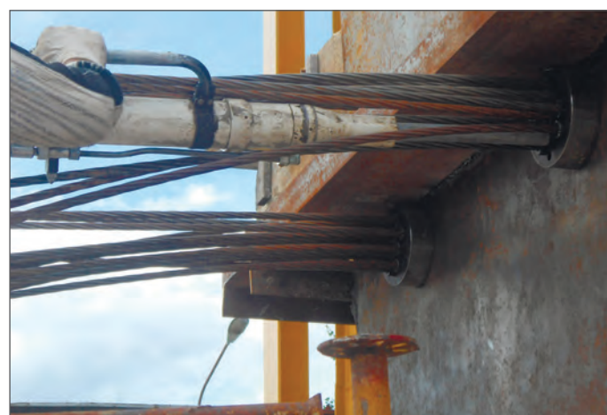
Фото 2. Установка металлического листа, натяжение прядей
