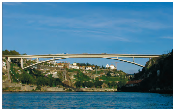
Рис. 13. Арочный городской мост через р. Дуэро (источник//ru-travel.livejournal.com)
