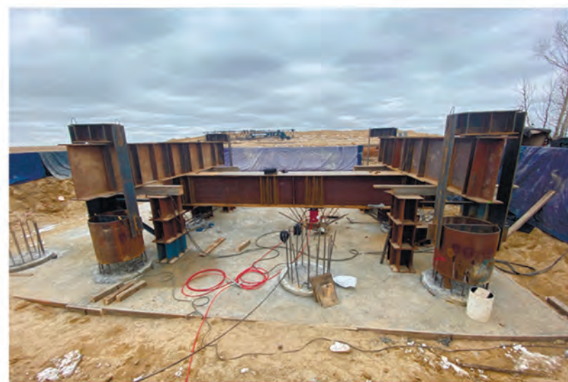
Испытания грунтов статической вертикальной вдавливающей (выдергивающей) нагрузкой буровой сваи
