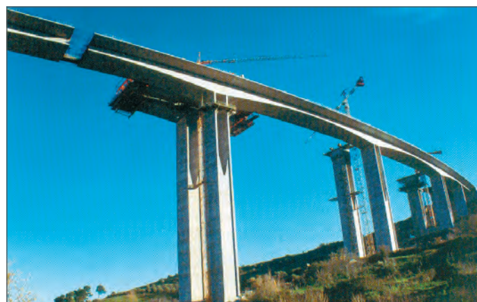
Рис. 14. Строительство рамного виадука с парными стойками в верхних частях промежуточных опор [6]
