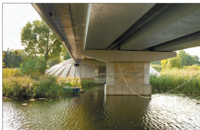
Фото 9. Вид снизу после ремонта
