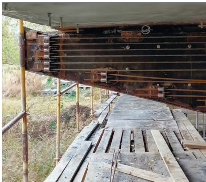
Фото 7. Установка и натяжение арматурных канатов на ригелях
