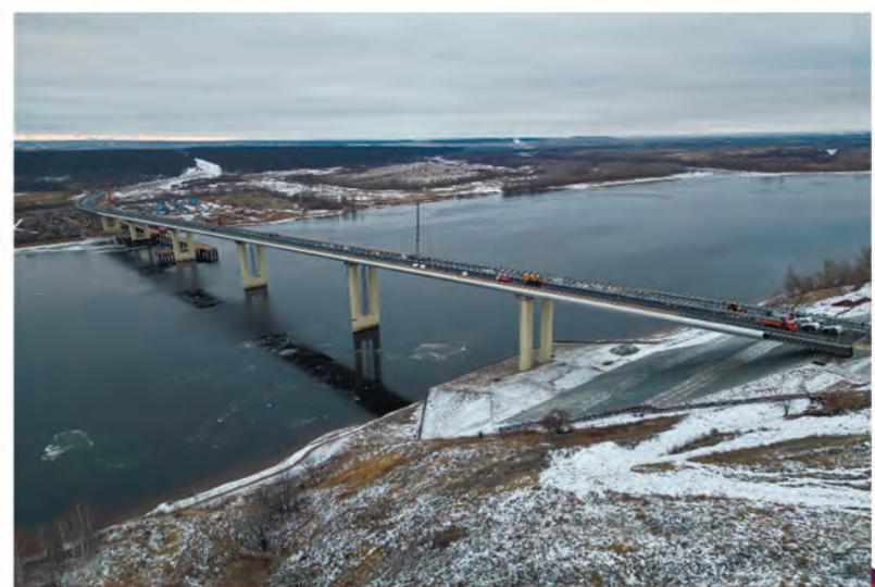
Испытания моста через реку Кама на обходе г. Нижнекамска и г. Набережные Челны
