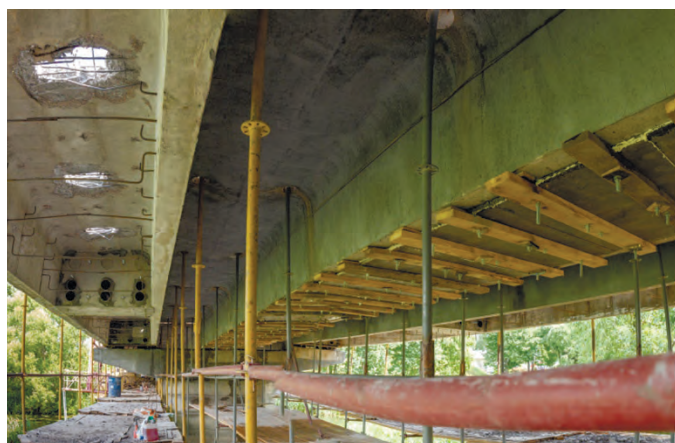
Фото 8. Работа с подвесных подмостей
