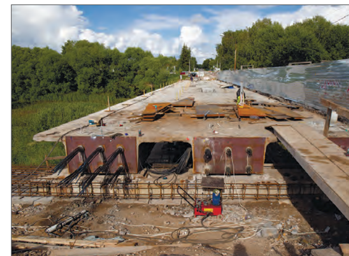
Фото 6. Преднапряжение пучков в коробке
