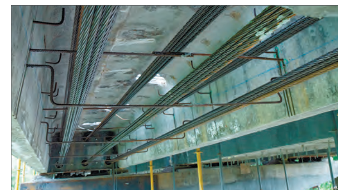
Фото 5. Канаты преднапряжения 6х12 прядей Ø 15,7 мм
