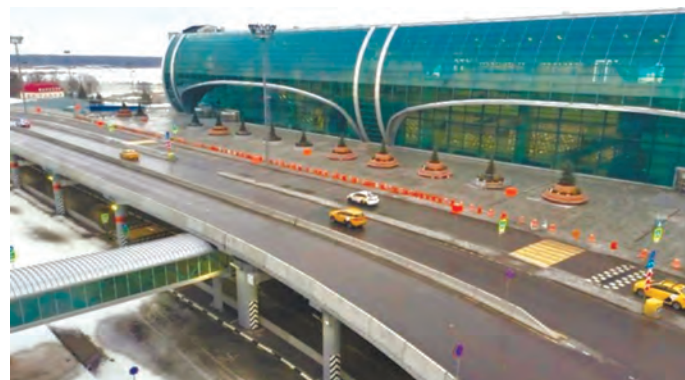
Рис. 7. Притерминальная эстакада в аэропорту Домодедово
