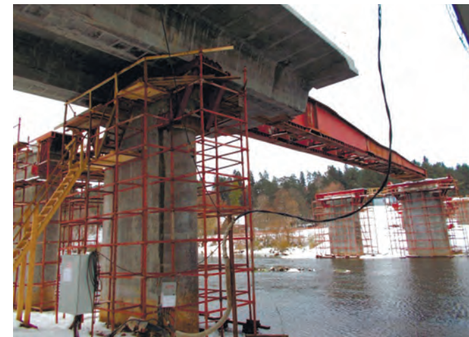
Рис. 11. Мост на ЦКАД в районе Волоколамска, надвигающийся железобетонный пролетный строения
