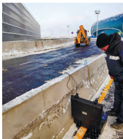
Рис. 8. Проведение динамических испытаний пролетных строений на эстакаде в Домодедово
