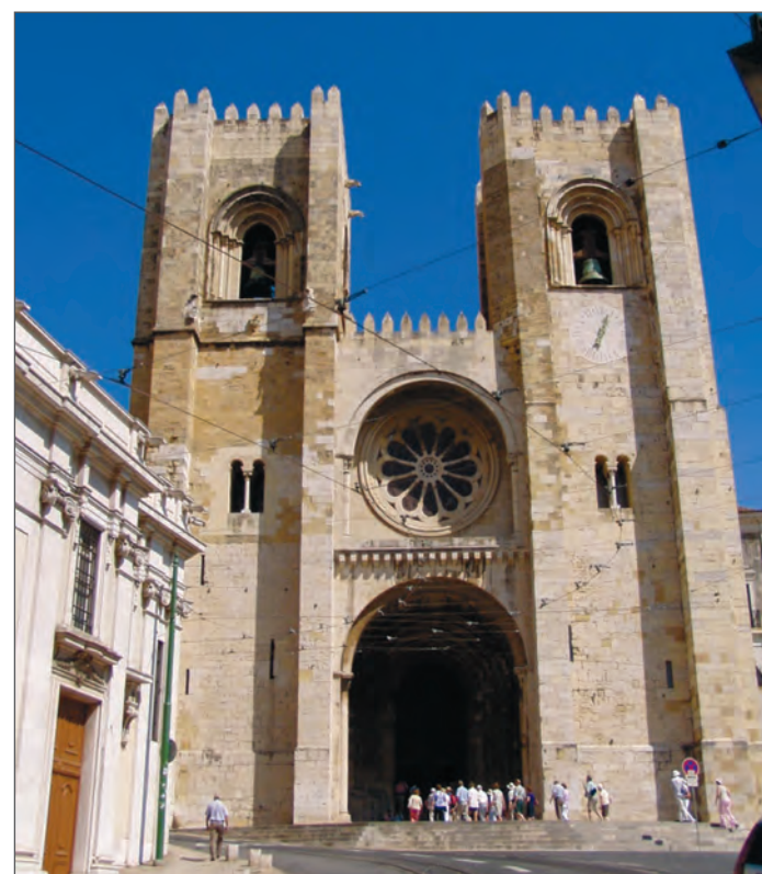
Рис. 5. Кафедральный собор Лиссабона построен в 1150 году. Верхний ярус здания, поврежденный землетрясением 1755 года, впоследствии был капитально отремонтирован (фото автора)
