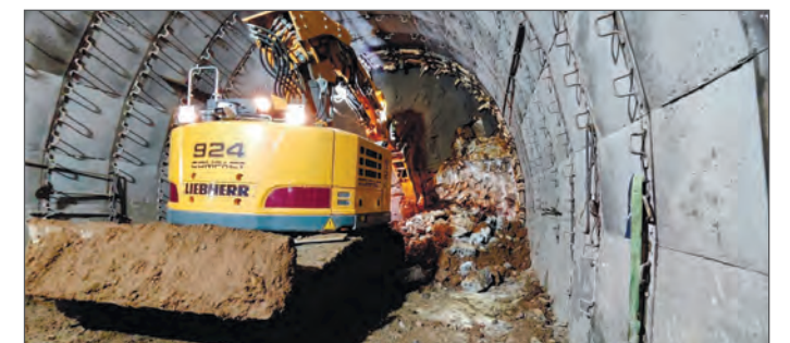
Рис. 6. Механизированная проходка верхнего уступа тоннеля
