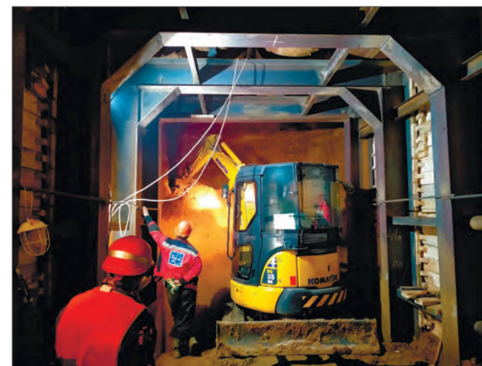
Рис. 19. Проходка верхнего яруса продольной штольни
