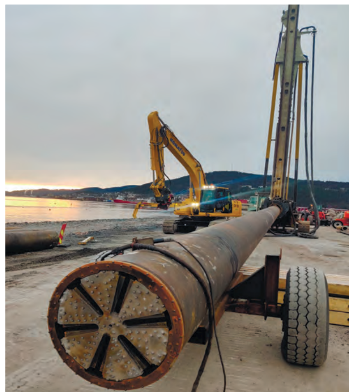
Рис. 4. Свая 630 мм с пилотным долотом и кольцевой коронкой
