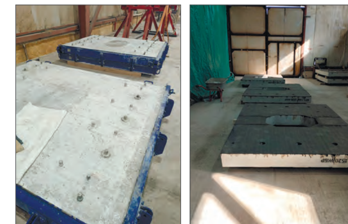
Рис. 12, 13. Бетонирование рам МГР и их оклейка материалом «Техноэластмост»
