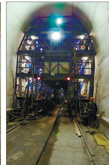
Рис. 11. Устройство постоянной обделки механизированной опалубкой «Гамма»
