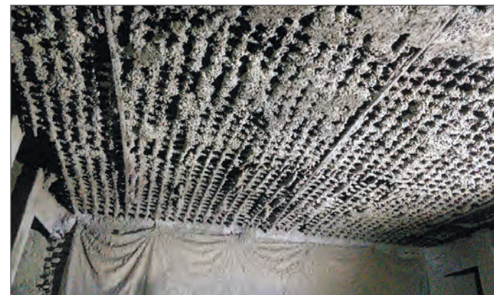
Рис. 24. Промежуточный этап нанесения набрызгбетона по арматурному каркасу потолочной поверхности
