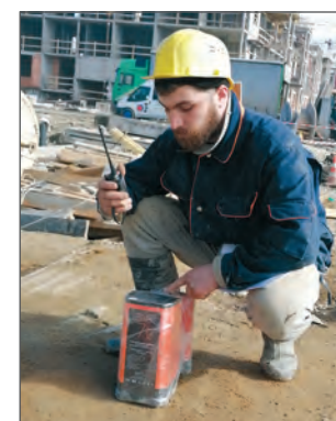
Замер глубин и уклонов локатором
