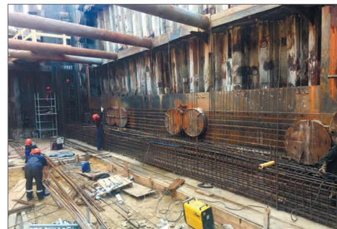
Рис. 8. Армирование нижней лотковой части порталной рамы
