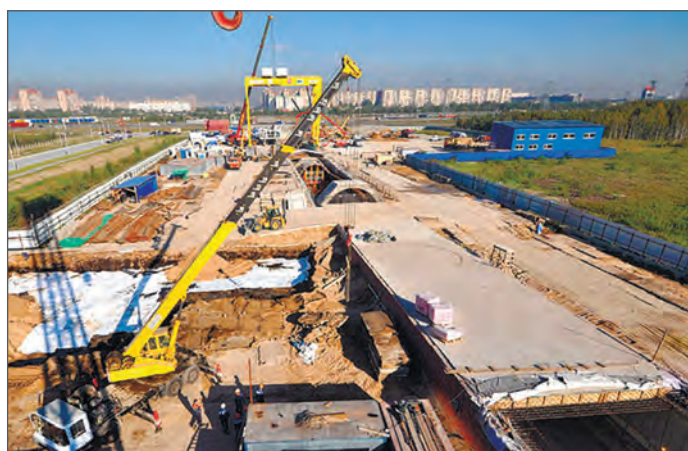
Строительная площадка станции метро «Южная» в Санкт-Петербурге
