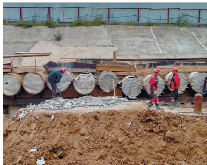
Рис. 18. Отклонения труб экрана при их продавливании
