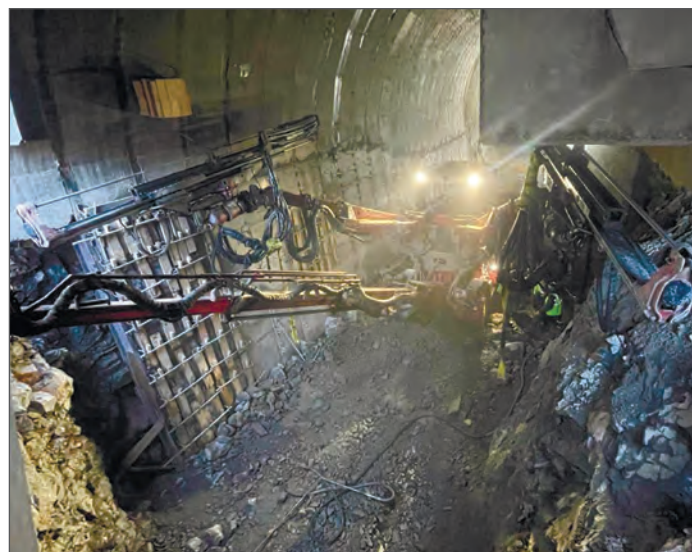
Рис. 8. Проходка нижнего уступа со стороны Восточного портала
