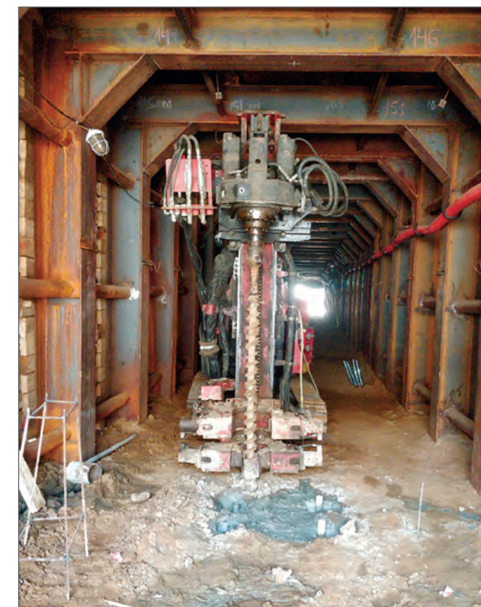
Рис. 21. Выполнение работ по цементированию основания верхнего яруса продольной штольни
