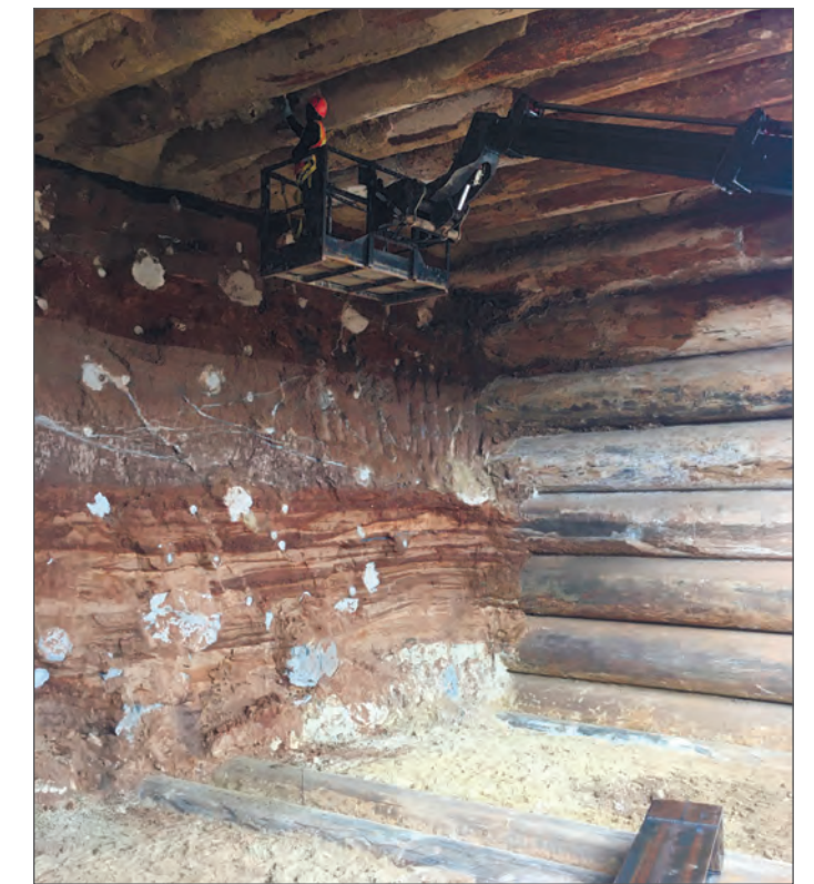
Рис. 9. Лоб забоя, закрепленный горизонтальными грунтоцементными сваями
