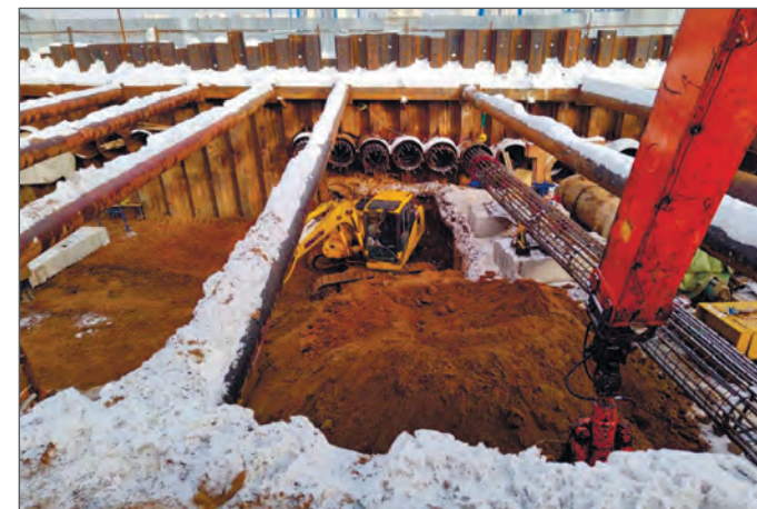
Рис. 7. Установка арматурных каркасов в трубы защитного экрана
