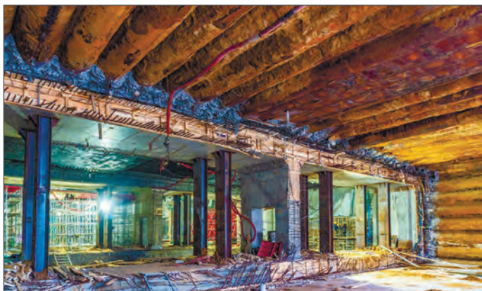
Рис. 23. Опорный участок тоннельной обделки, предварительно сооруженный в поперечной штольне
