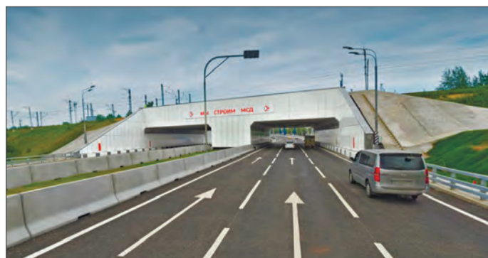
Рис. 11. Вид на портал действующего тоннеля №1 на участке ЮВХ-9.5
