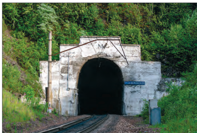
Рис. 1. Вид на Восточный портал старого 1-го Джебского тоннеля
