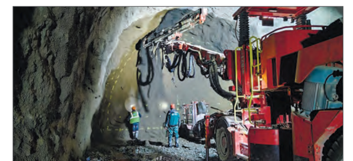
Рис. 7. Проходка буровзрывным способом верхнего уступа тоннеля
