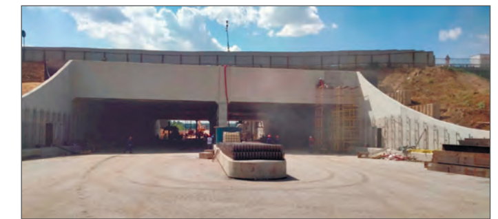
Рис. 26. Подготовка тоннеля к пуску автомобильного движения
