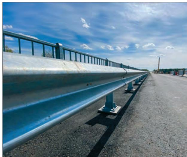
испытывается воздействием на него легкового автомобиля и автобуса (или грузового автомобиля).
